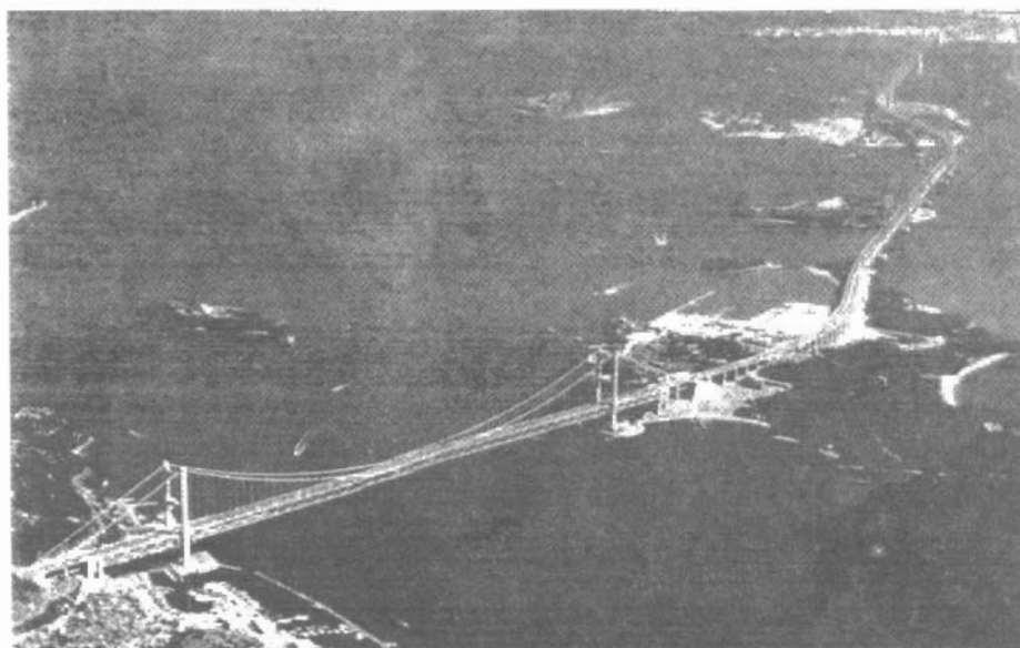
Hình 21 Cầu Sétô Ôhashi nối hai đảo Hônsu và Sicôcư
