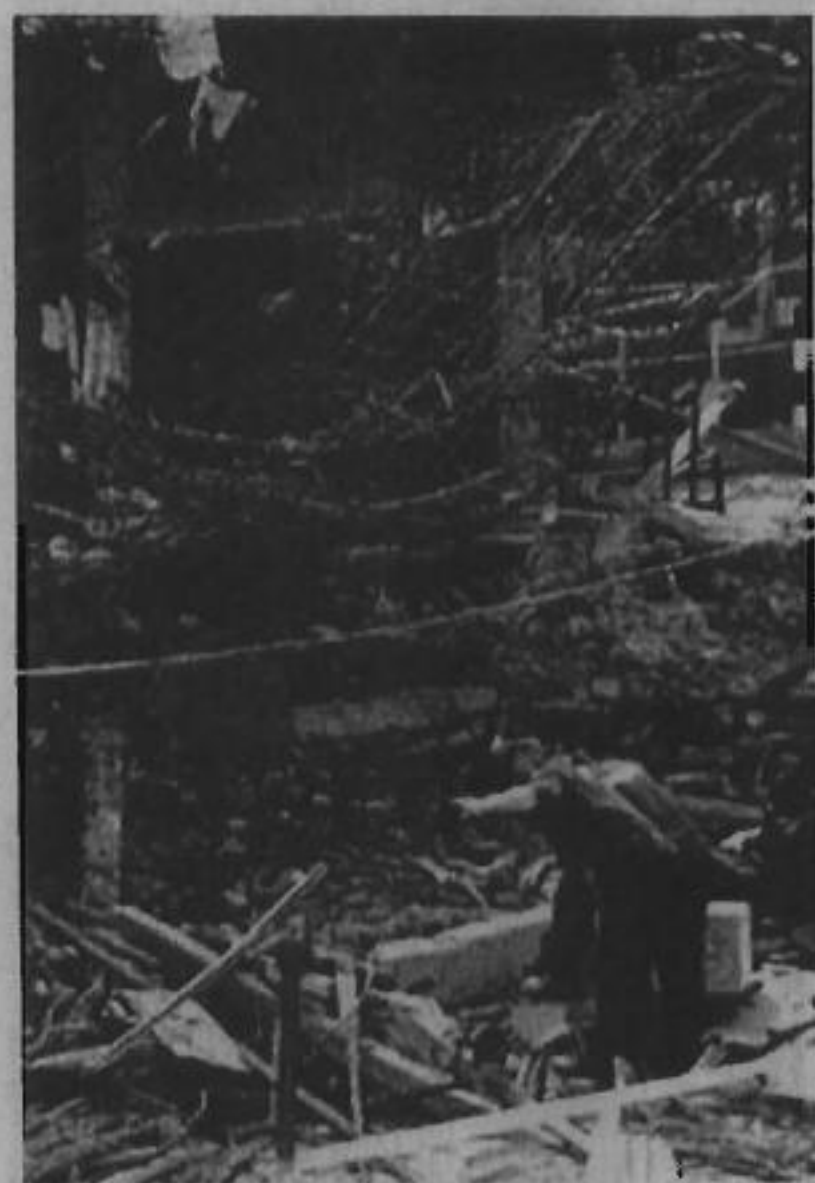
Bê-tông cốt sắt chỉ còn lại cốt sắt và thi thể của hơn 200 nạn-nhân
