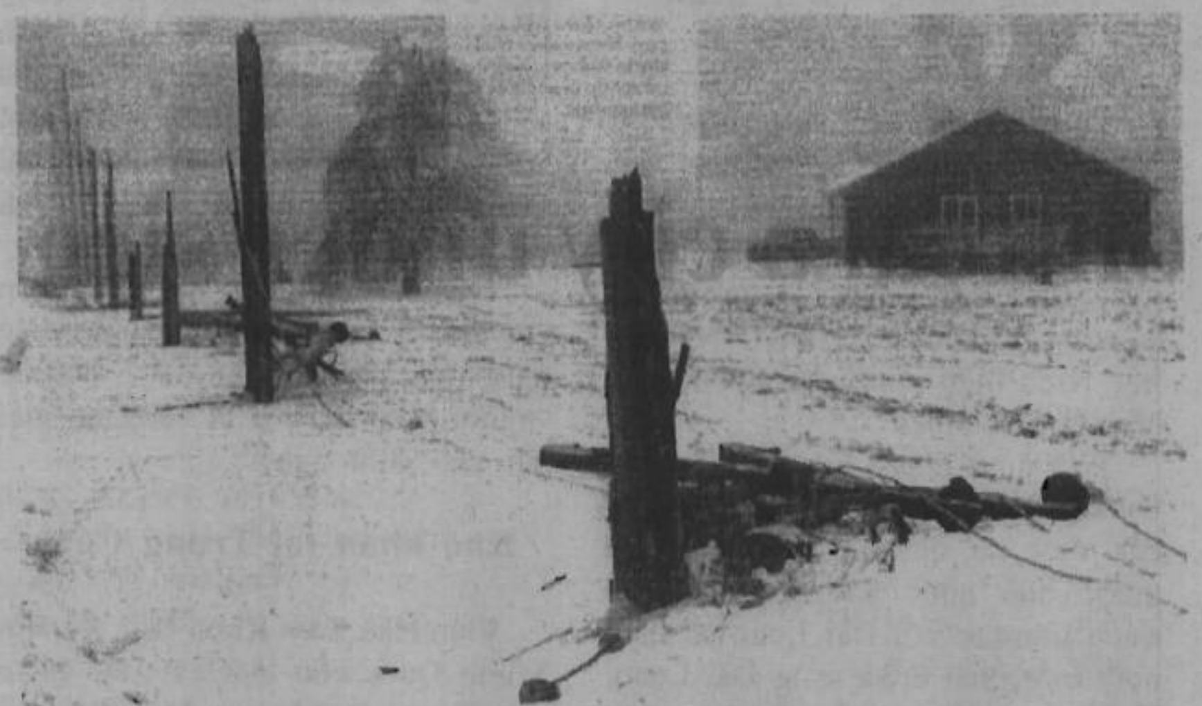
30.000 trụ điện gãy gục tại miền Đông Ontario và Québec dưới mưa băng
