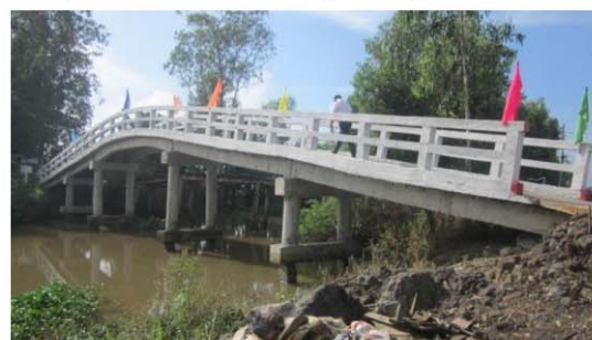
Cầu Khánh Thành
