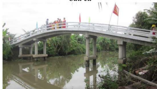
Cầu hoàn thành
