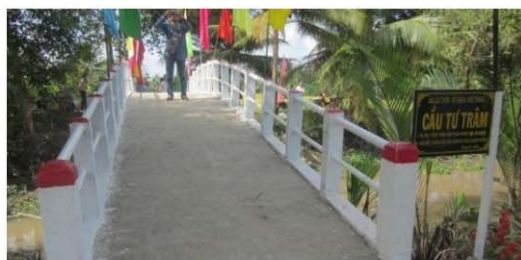
Cầu hoàn thành
