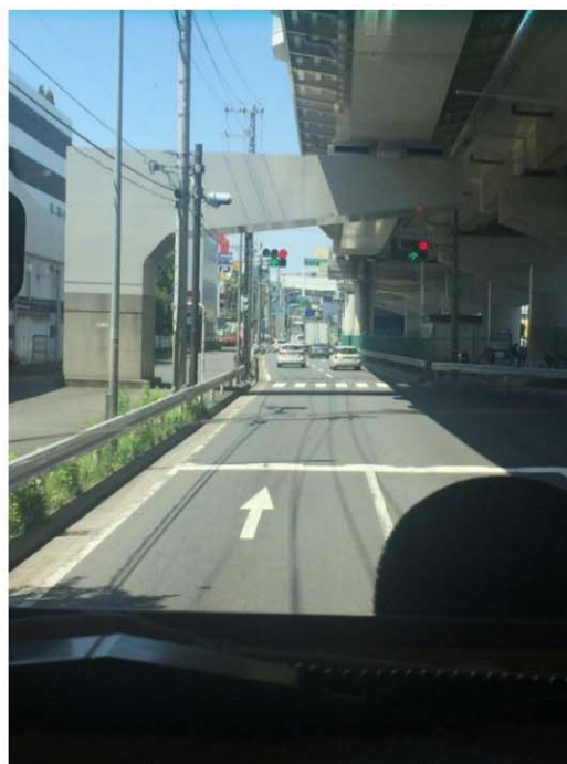
Một trụ cầu lạ mắt trên đường đến hải cảng Yokohama
