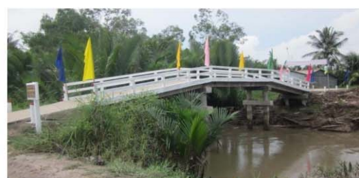
Cầu hoàn thành
