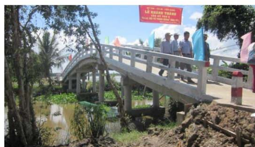
Cầu Khánh Thành
