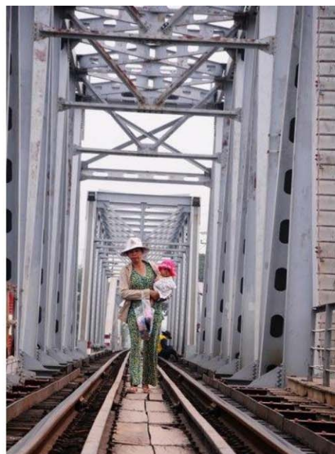
Đường xe lửa Cầu Bình Lợi
