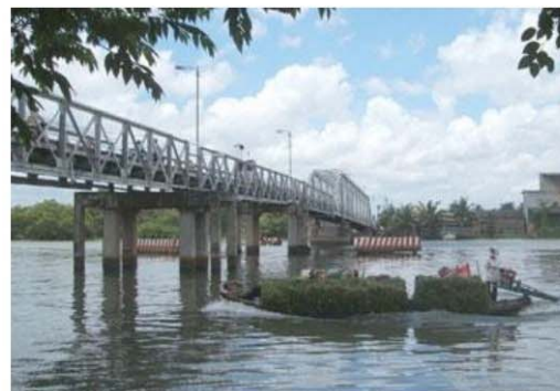
Cầu Phú Long cũ (cầu sắt Lái Thiêu)
