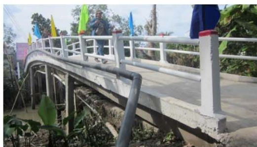
Cầu hoàn thành
