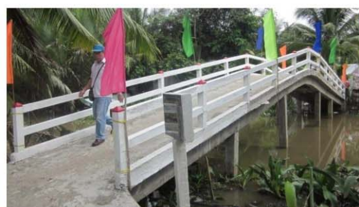
Cầu hoàn thành
