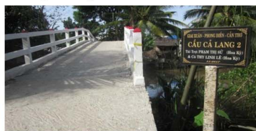
Cầu hoàn thành
