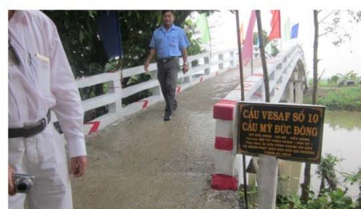
Cầu hoàn thành
