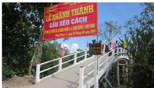
Cầu hoàn thành
