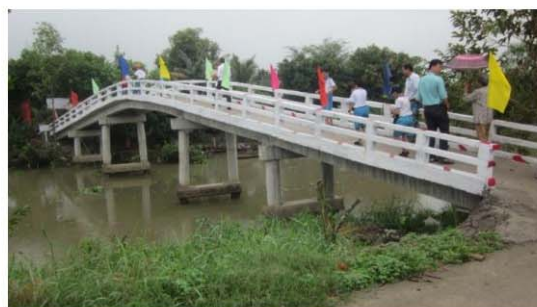
Cầu hoàn thành
