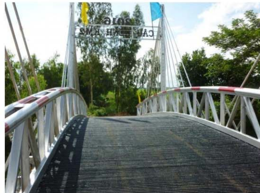
Cầu khánh thành
