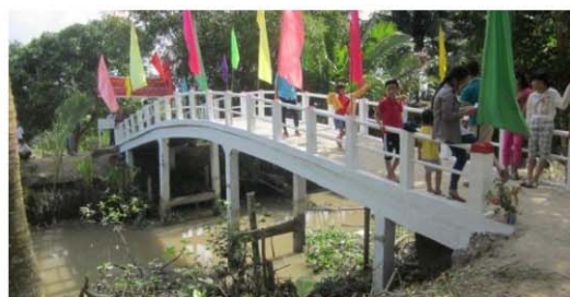
Cầu hoàn thành
