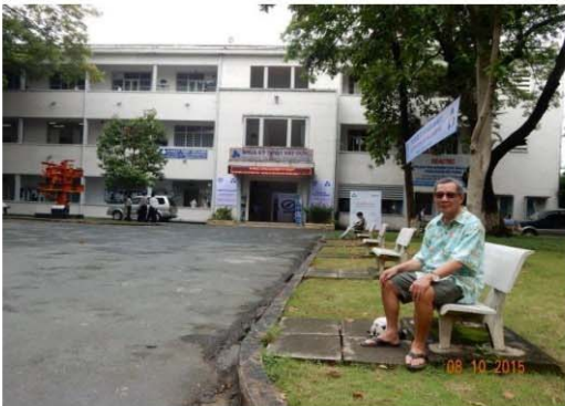
Trước trường Cao Đẳng Công Chánh cũ, nay đổi thành Khoa Kỹ Thuật Xây Dựng, Đại Học Bách Khoa TP HCM
