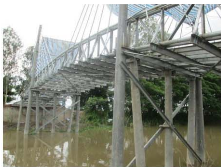
Cầu đang thi công
