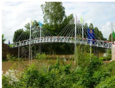
Cầu hoàn thành
