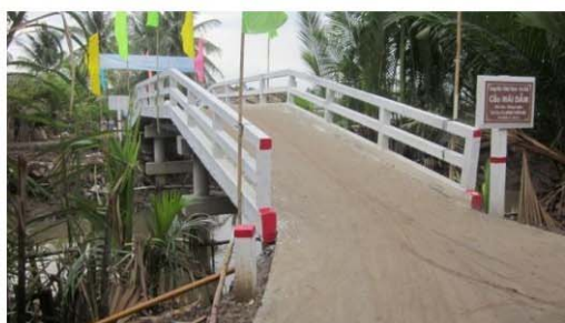
Cầu hoàn thành
