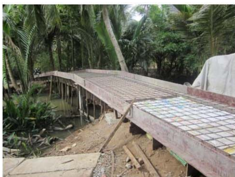
Trải sắt cho mặt cầu
