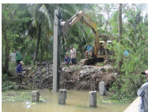
Đóng cốp bê tông
