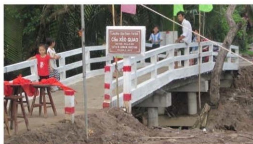
Cầu hoàn thành
