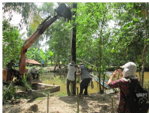
Công tác hạ cọc
