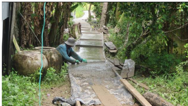
Công tác làm đường đan
