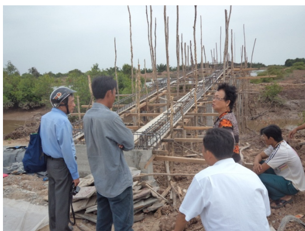
2/ Kiểm thép cầu Đoàn Kết.
