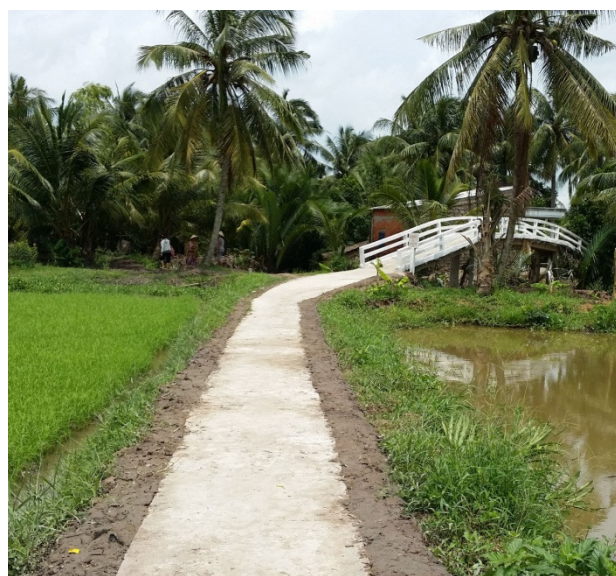
Đường đan bê tông vào cầu Xóm Chòi 2
