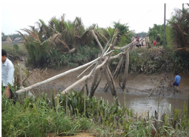
5/ Cầu Xẻo Lớn cũ.
