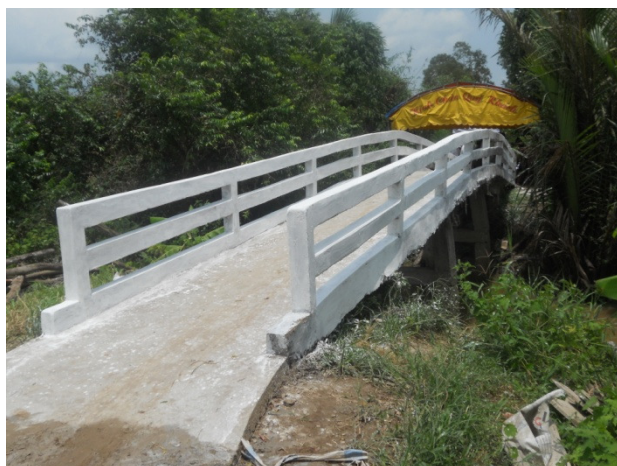
Cầu Vàm Buôn 2 hoàn thành.
