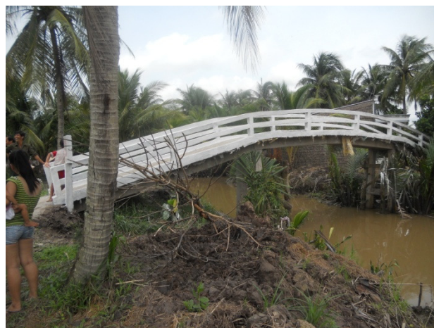
Cầu Xóm Chòi 2 hoàn thành.
