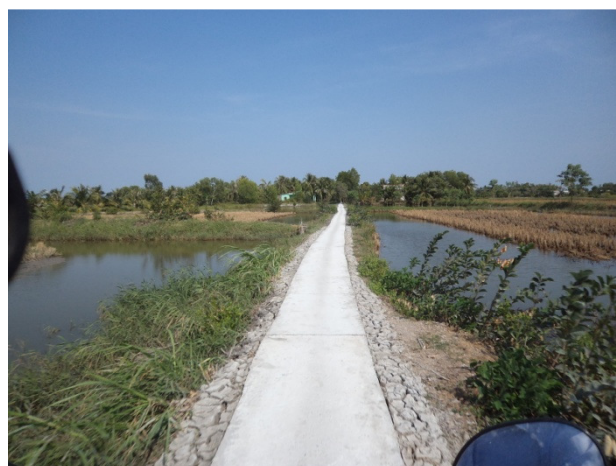
10,11,12 / Đường vào cầu Kênh 16 hoàn thành
