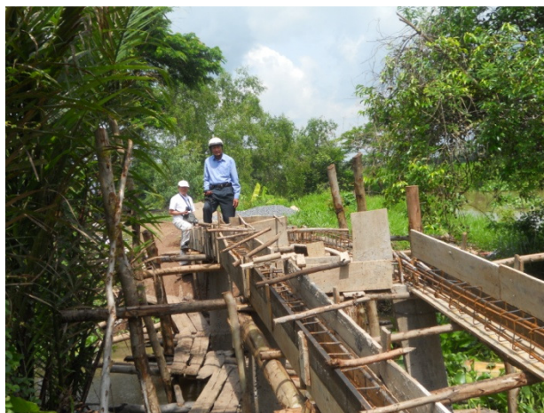
Thi công cầu Vàm Buôn 2.
