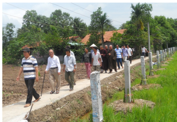
4-Đoạn đường đan BT hoàn thành
