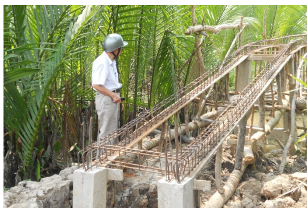
Kiểm tra cốt thép cầu
