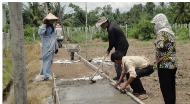
2-Thi công đường đan BT .
