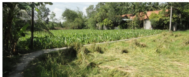
1-Đoạn đường trước khi thi công .
