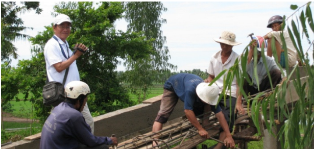
Chuẩn bị đổ bê tông cầu, AH Sâm đang quay phim.
