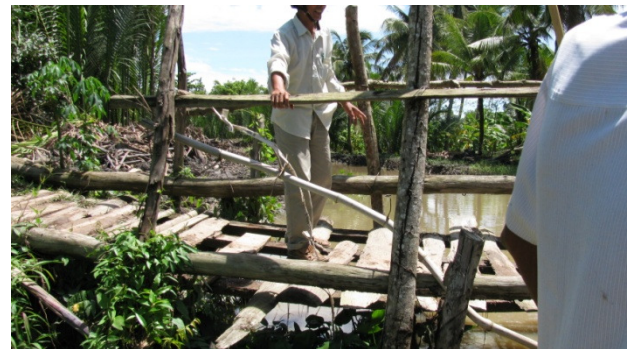
Cầu Bung Sen II cũ đã mục. Đề nghị xây lại bằng bê tông
