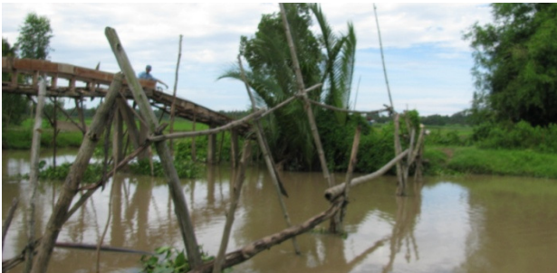
Cầu Khe cũ bên cạnh cầu bê tông đang xây dựng.
