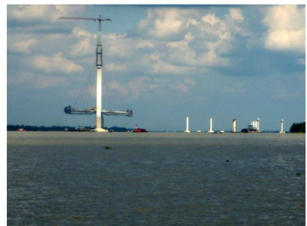
Công trình xây cất tru cầu dây văng Cần Thơ
