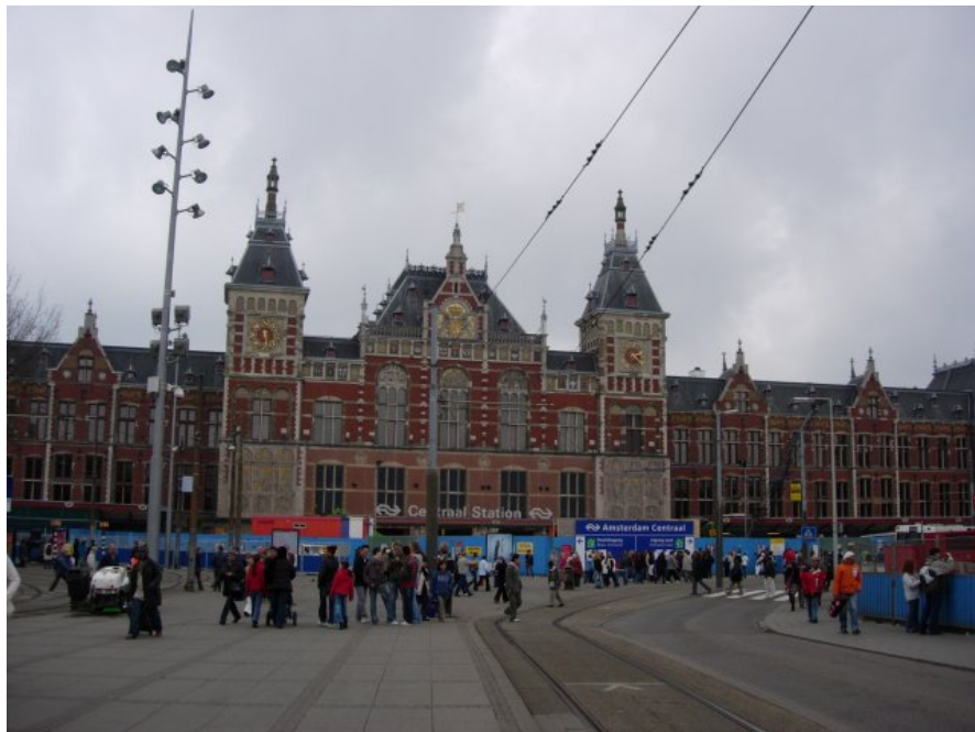
Nhà ga Central Station ở Amsterdam.
