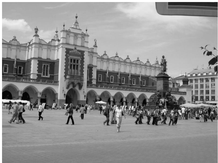
Công trường chính ở cố đô Krakow
