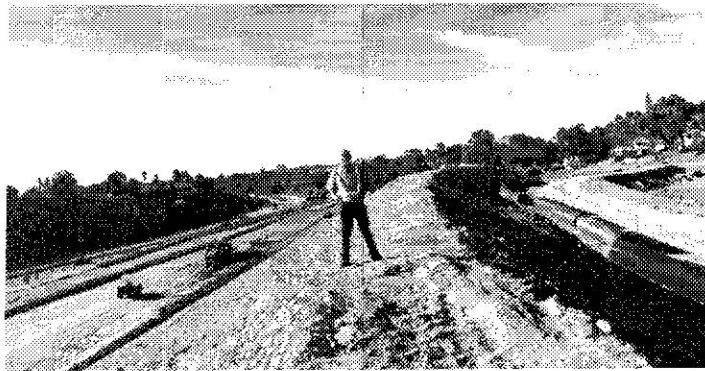
Đứng trên cao, phía tay phải là công viên Park de la Crue đang được xây dựng, tay trái là freeway I-15 đang được xẻ, cắt, đào, đắp (hướng Southbound). Hướng Northbound đã được xây dựng xong phía bên trái
