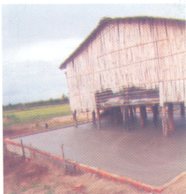
Thành chuồng làm bằng tre lũa
