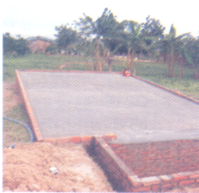
Nền chuồng dẽ bằng xi măng
