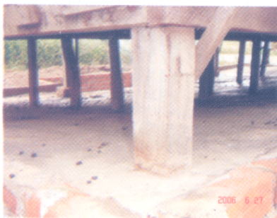
Chân đỡ chuồng dê bằng cột gỗ
