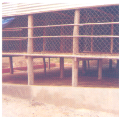
Thành chuồng xây bằng lưới B40
