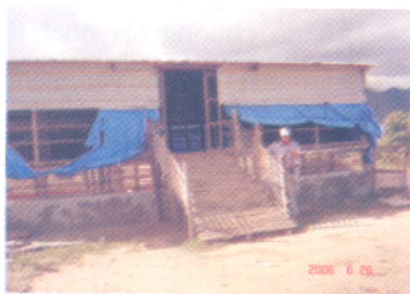
Cửa chuồng làm bằng tre, gỗ và lưới B40
