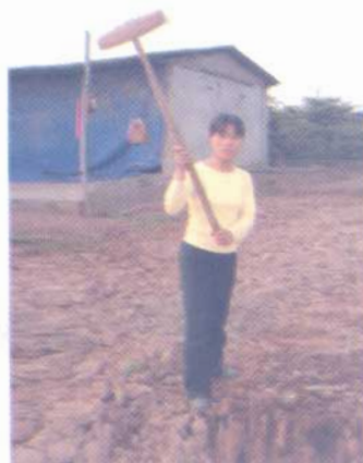
b) Sử dụng vó đập đất
