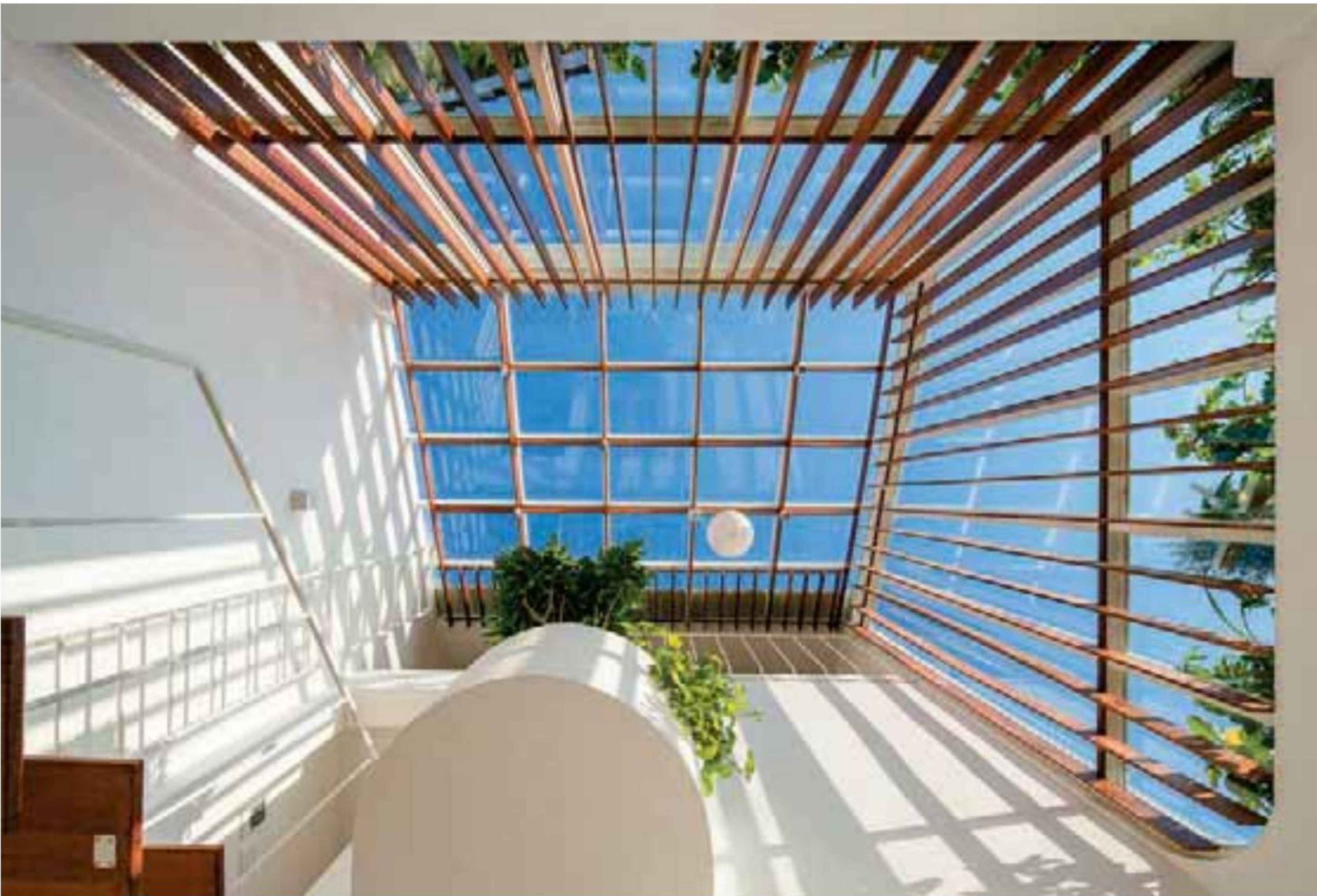
Nhóm thiết kế đã sử dụng các ô cửa sổ bằng lam gỗ để các vệt nắng trong ngày như “xuyên qua kẽ lá” vào từng không gian bên trong
