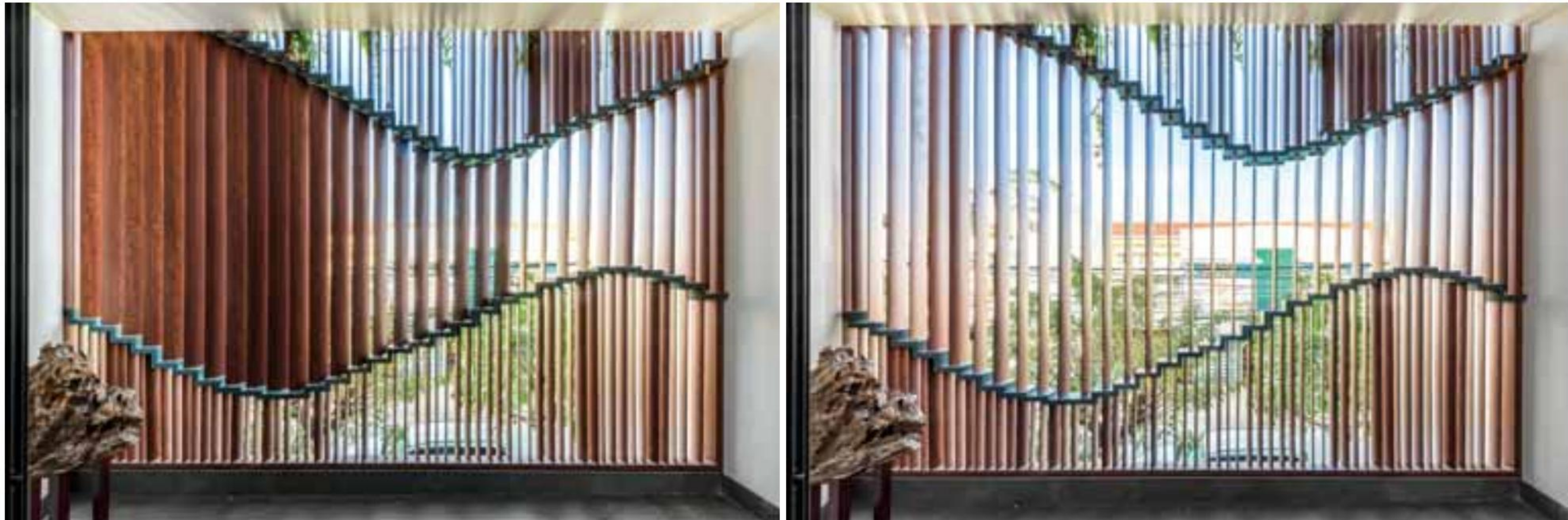
Lam xoay linh hoạt tạo sự thay đổi về ánh sáng và tầm nhìn ra khung cảnh bên ngoài
