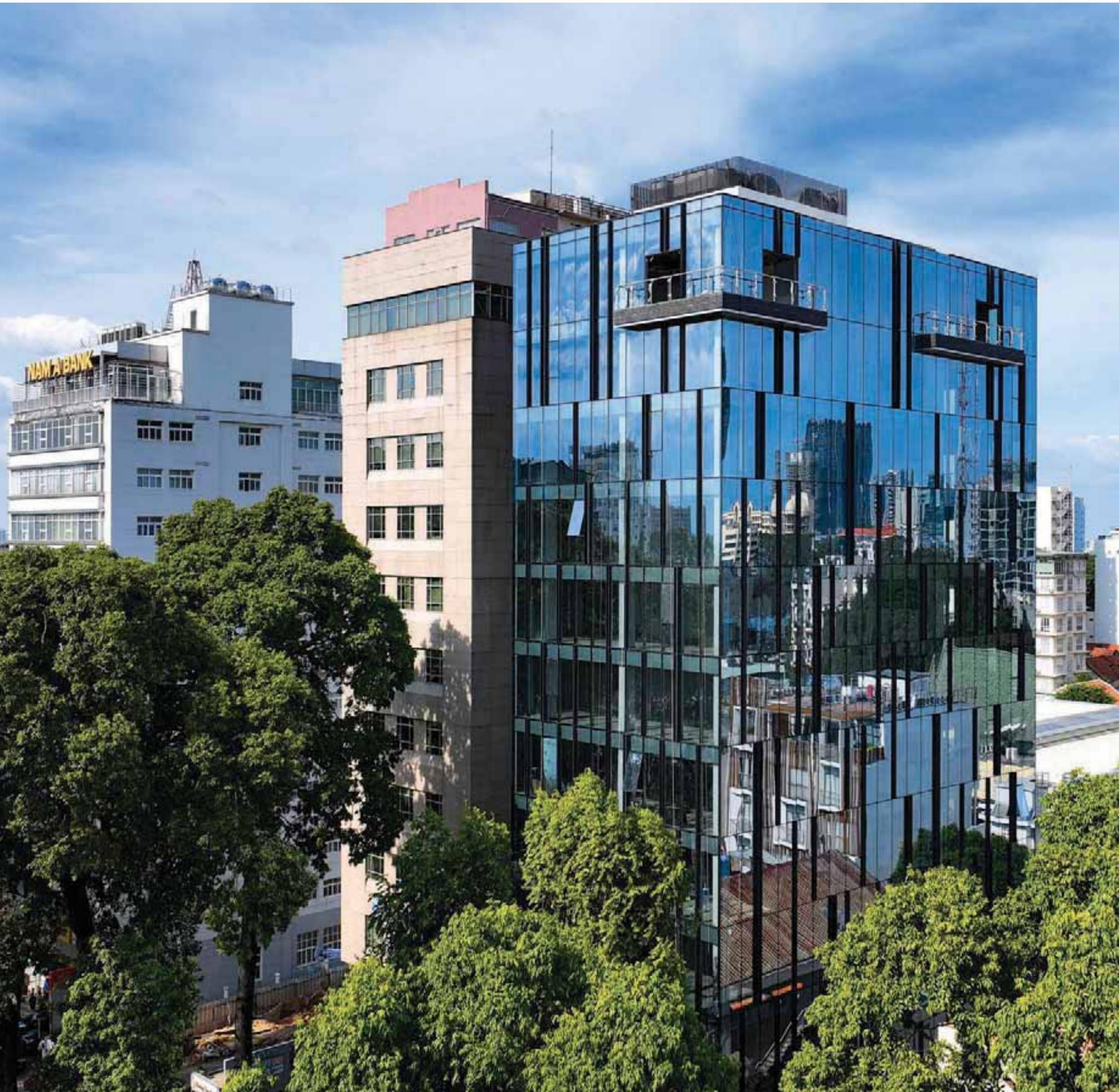
NEXX BUILDING - QUẬN 3, THÀNH PHỐ HỒ CHÍ MINH Toà nhà văn phòng được thiết kế theo phong cách hiện đại và tối ưu tiết kiệm năng lượng khi sử dụng dòng kính cao cấp nhập khẩu Insulated Low-E từ Viracon. Đây cũng là một trong những toà nhà tiên phong của thành phố có tầng hầm đầu xe được thiết kế lệch tầng để tối ưu diện tích và vị trí để xe. Mỗi khu vực văn phòng đều có vị trí cấp thoát nước riêng, đi kèm với các tiện ích được trang bị đầy đủ theo tiêu chuẩn quốc tế
