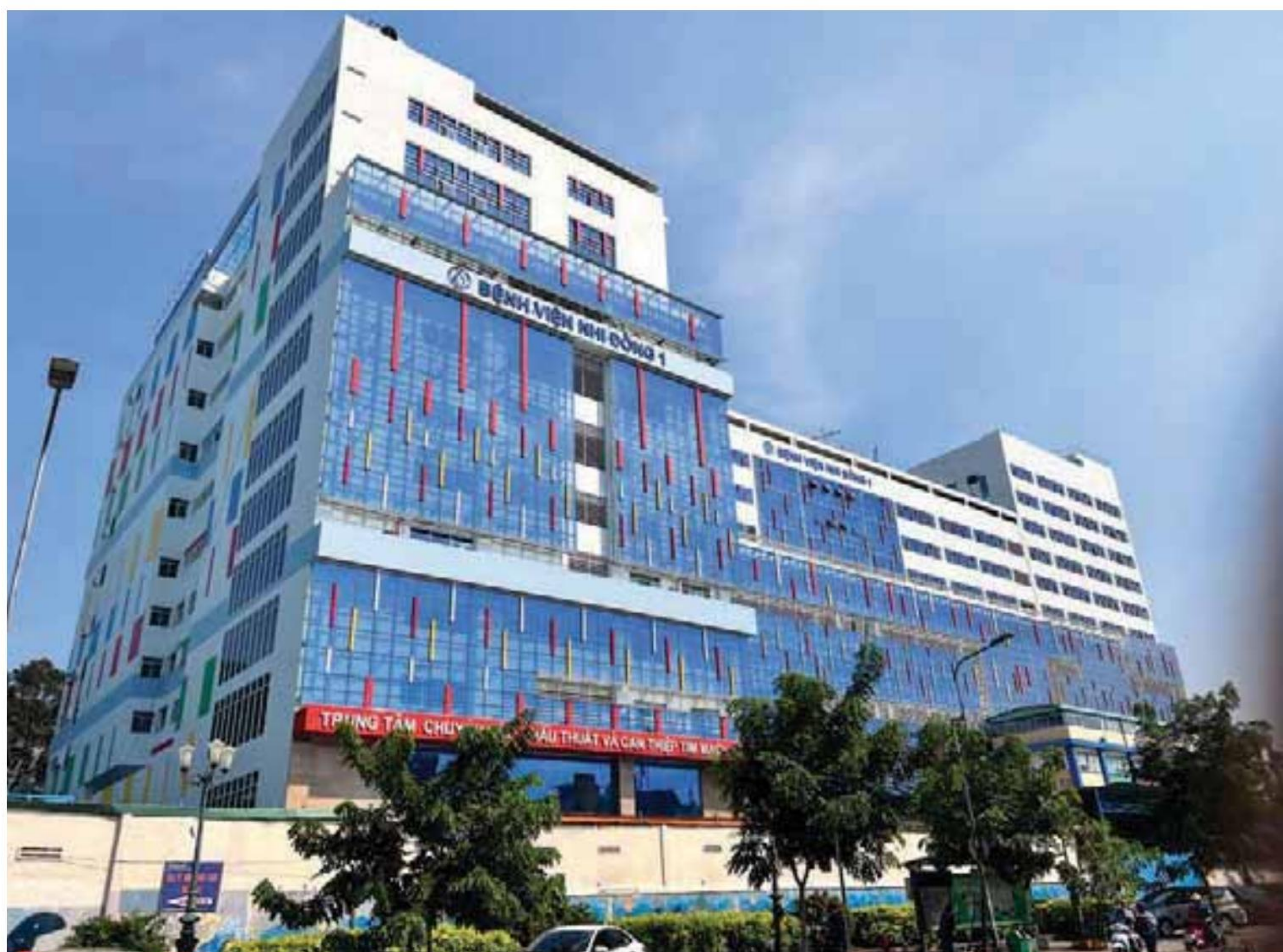
Intoc đã được Bệnh viện Nhi Đồng 1 TP.HCM chọn để thực hiện việc chống thấm cho công trình của mình
