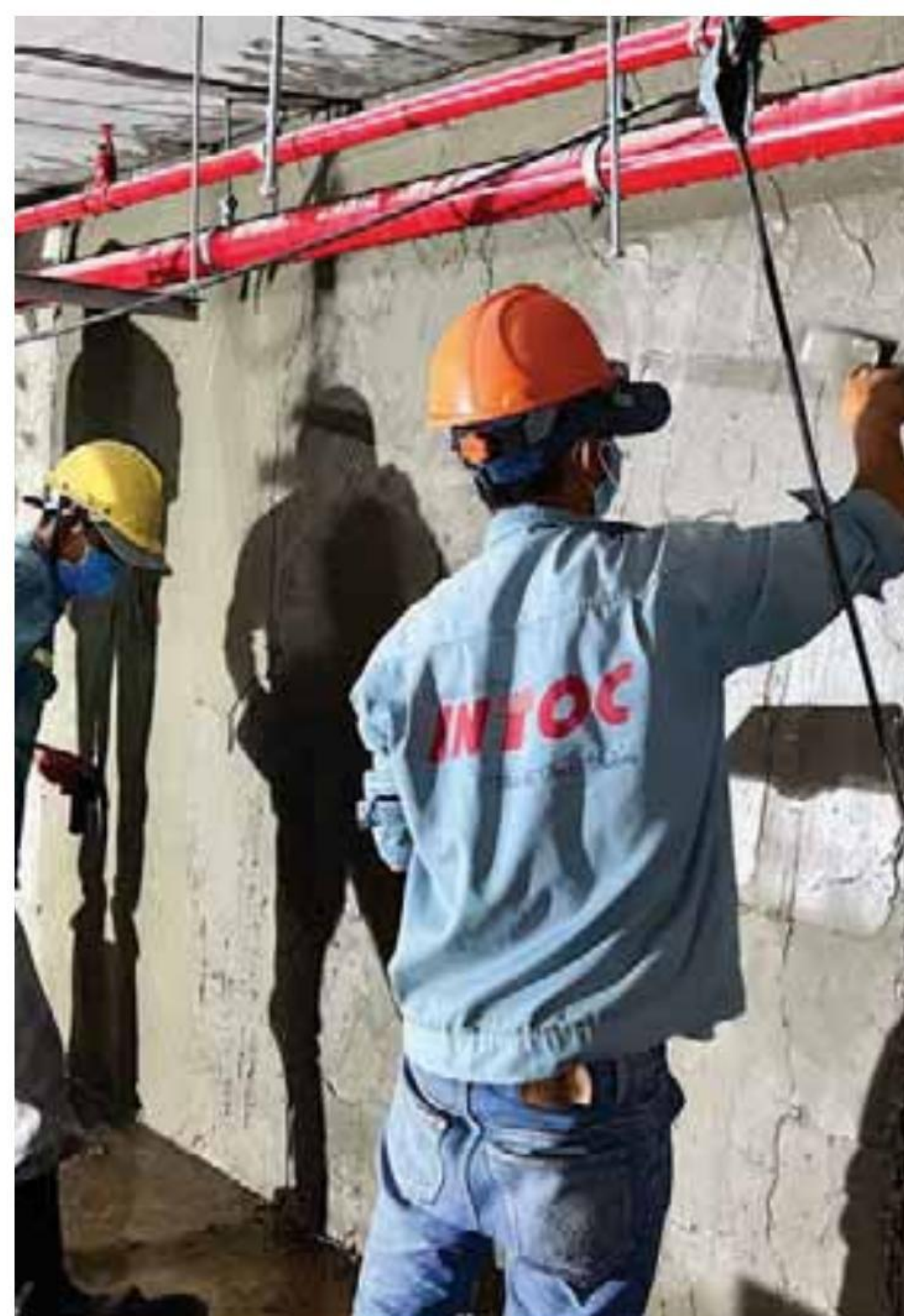
Các công nhân của Intoc đang thi công chống thấm cho một công trình
