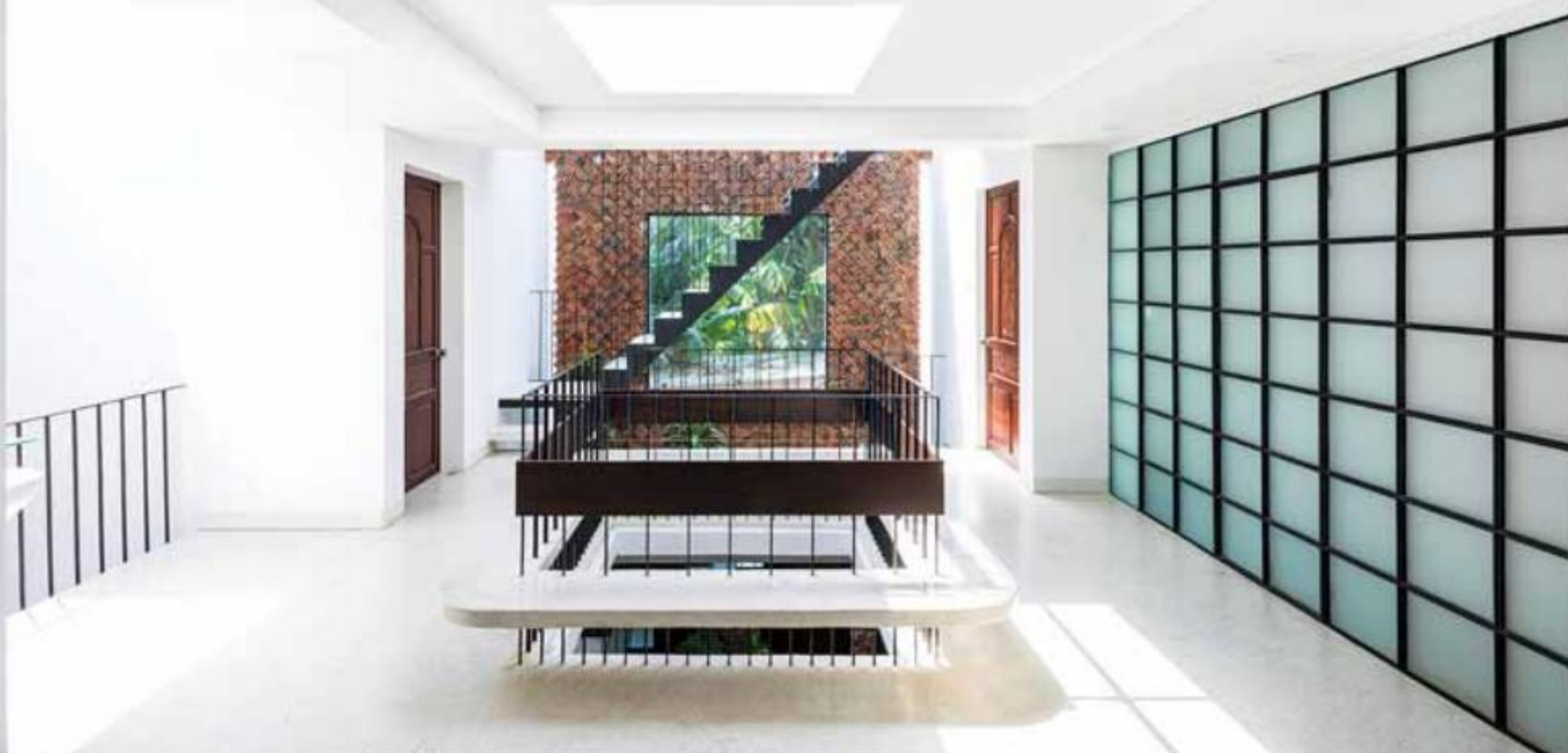
Giải pháp thông gió tự nhiên qua các giếng trời, hệ “tường thở” - gồm 2 yếu tố là hệ tường hờ và khoảng vườn đi kèm. Ảnh: Wall house - CTA
