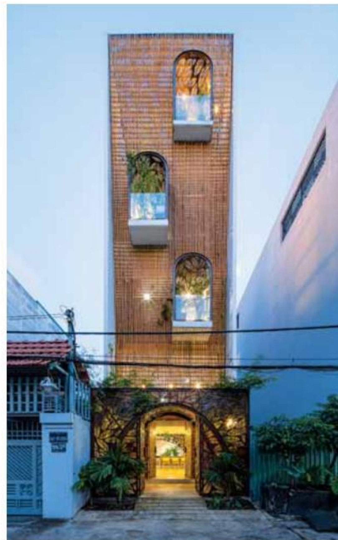
Mặt tiền với những mảng lam gió lớn được đục những lỗ nhỏ li ti, với những vật liệu nhẹ và dễ tái sử dụng sẽ giúp thông thoáng và còn tạo hiệu ứng thị giác khá tốt. Ảnh: atelier NgNg
