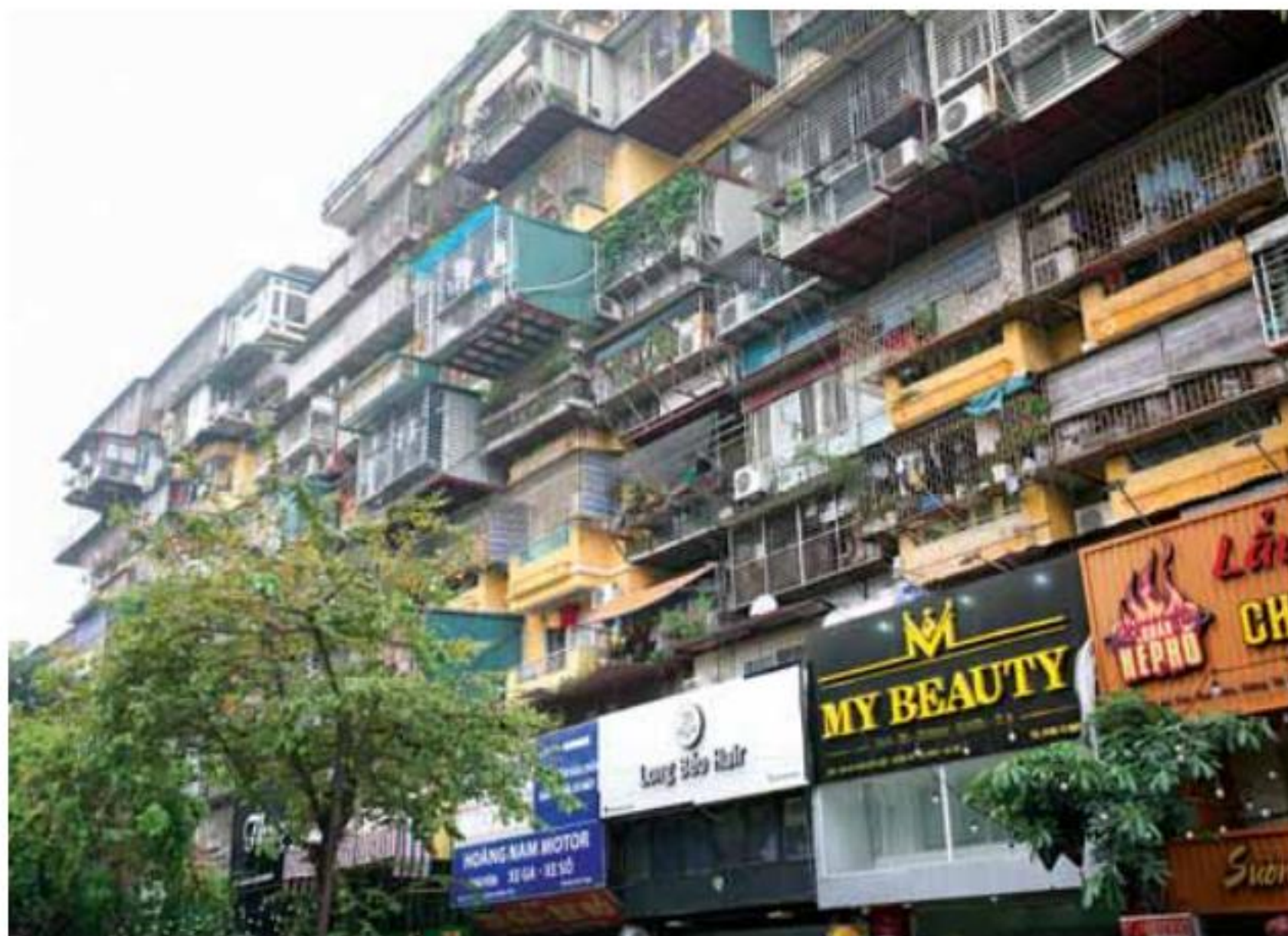
Nhà A6 khu tập thể Giảng Võ (quận Ba Đình, Hà Nội) là một chung cư cao 9 tầng có thang máy, hoàn thành xây dựng và sử dụng từ năm 2003. Nhưng đến nay công trình này trông không khác chung cư của thập niên 1970 bởi “chuồng cọp”
