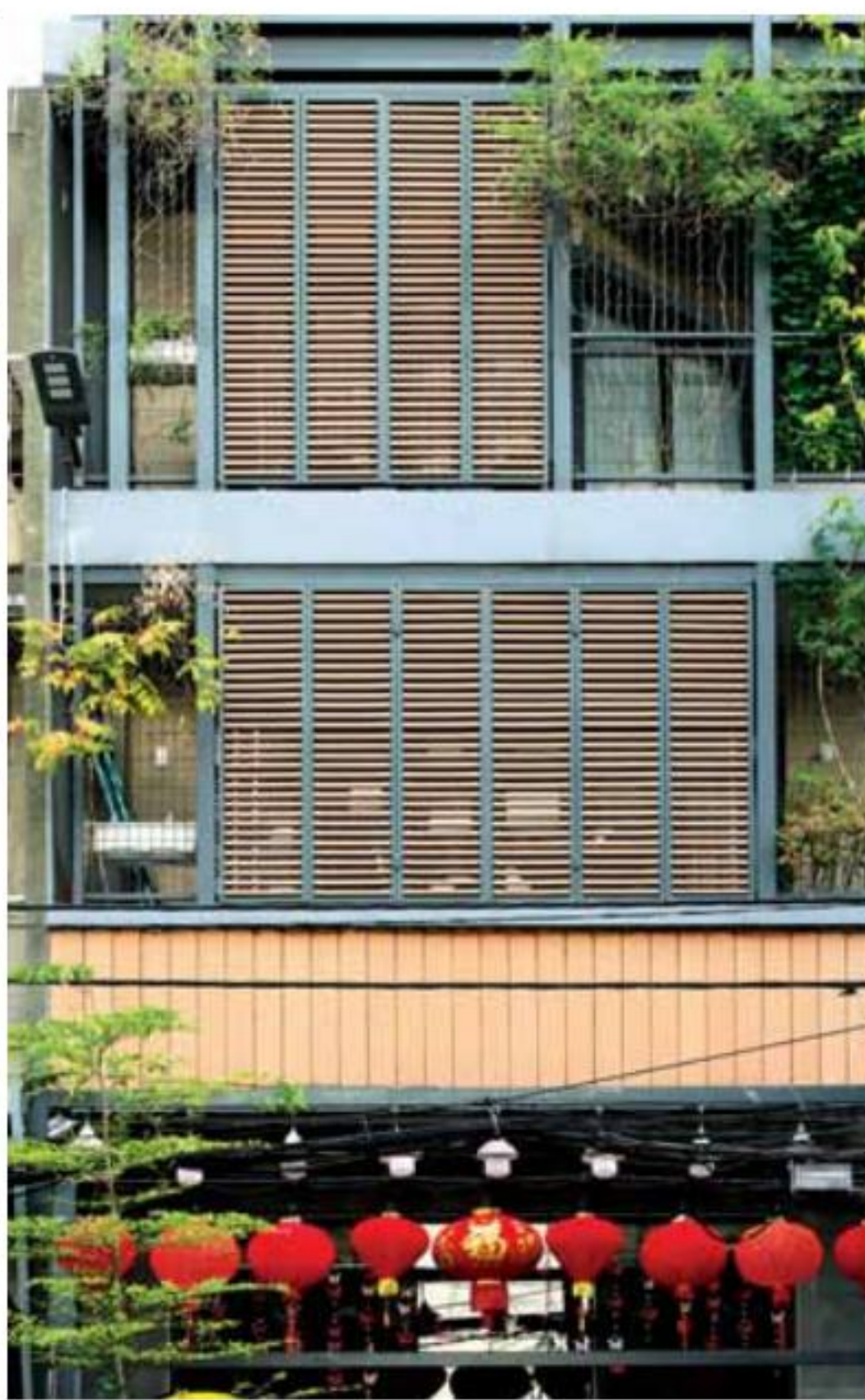
Mặt tiền khung sắt được đan cài vào khung bê tông cũ, kết hợp hệ lam xoay chuyển thành “lớp áo” che chắn hiệu quả cho ngôi nhà
