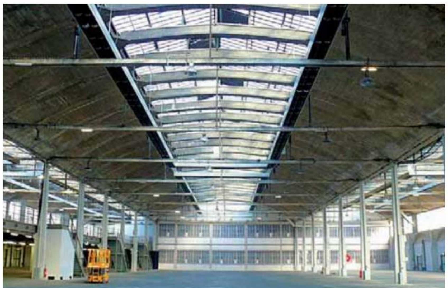
Les Halles Freyssinet trước khi cải tạo cho thấy, phân kết cấu đặc trưng vòm cuốn và hệ cột pyramide độc đáo
