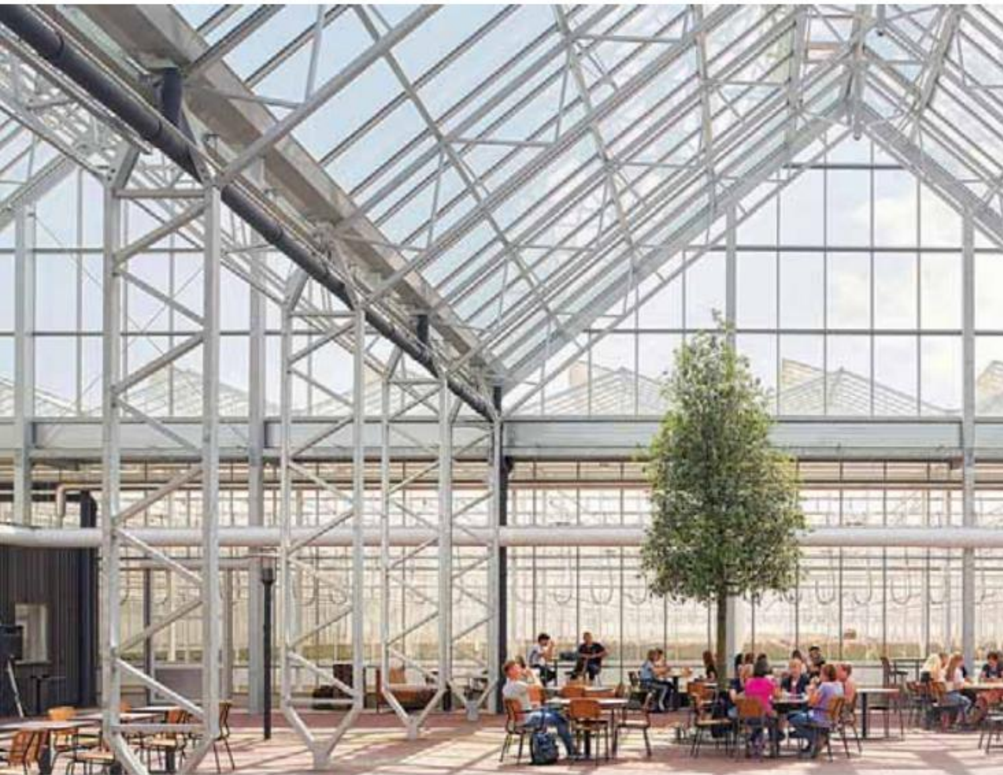
Ảnh trên Ống gió vải được lắp đặt tại công ty Schoneveld Breeding ở Hà Lan Ảnh dưới Ống gió vải được sử dụng cho tiệm cà phê ngoài trời ở Hà Lan
