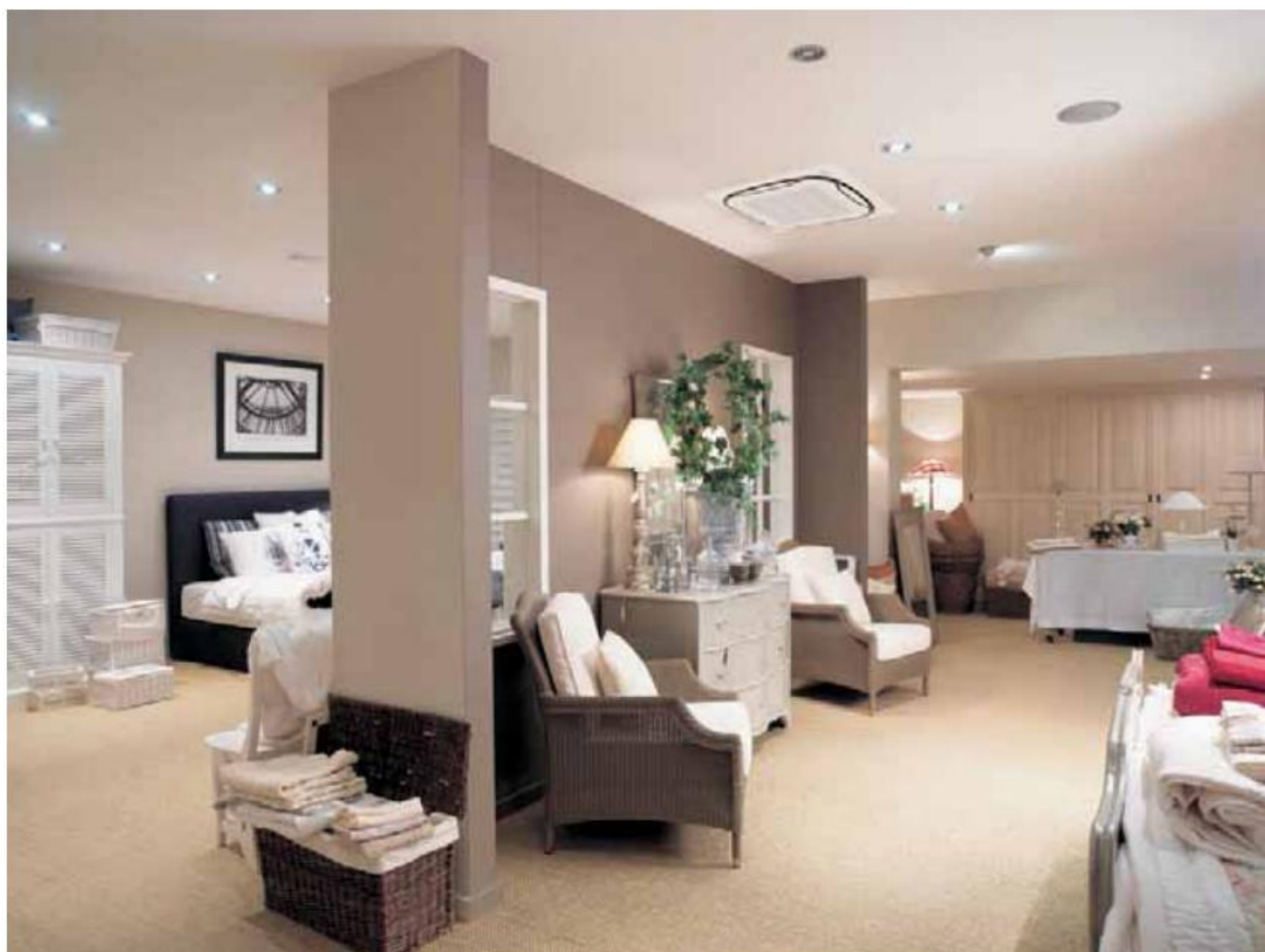
Máy lạnh âm trần được dùng cho những nhà lớn, chung cư... để từ một hệ thống lạnh có thể phân phối cho nhiều không gian riêng khác nhau (ảnh do Daikin cung cấp)
