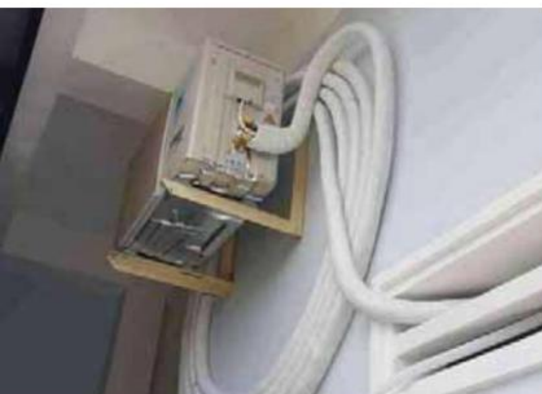
Một cách gán máy lạnh của thợ được cho là móc túi chủ nhà và lãng phí điện, vật tư... (ảnh internet)
