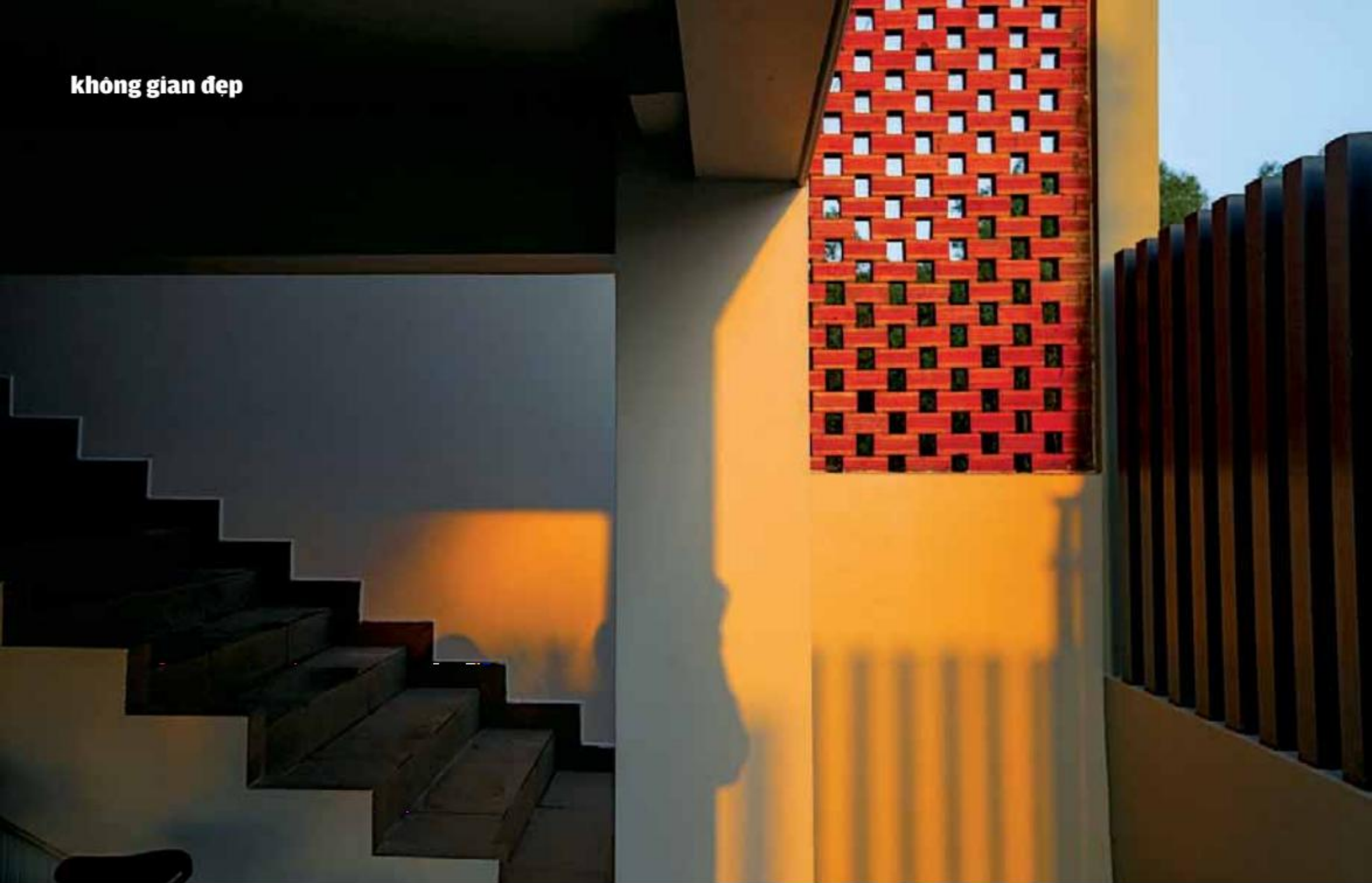
Bức tường bằng gạch xây vừa có tác dụng ngăn nắng vừa đón gió và tạo nét thẩm mỹ cho toàn bộ ngôi nhà
