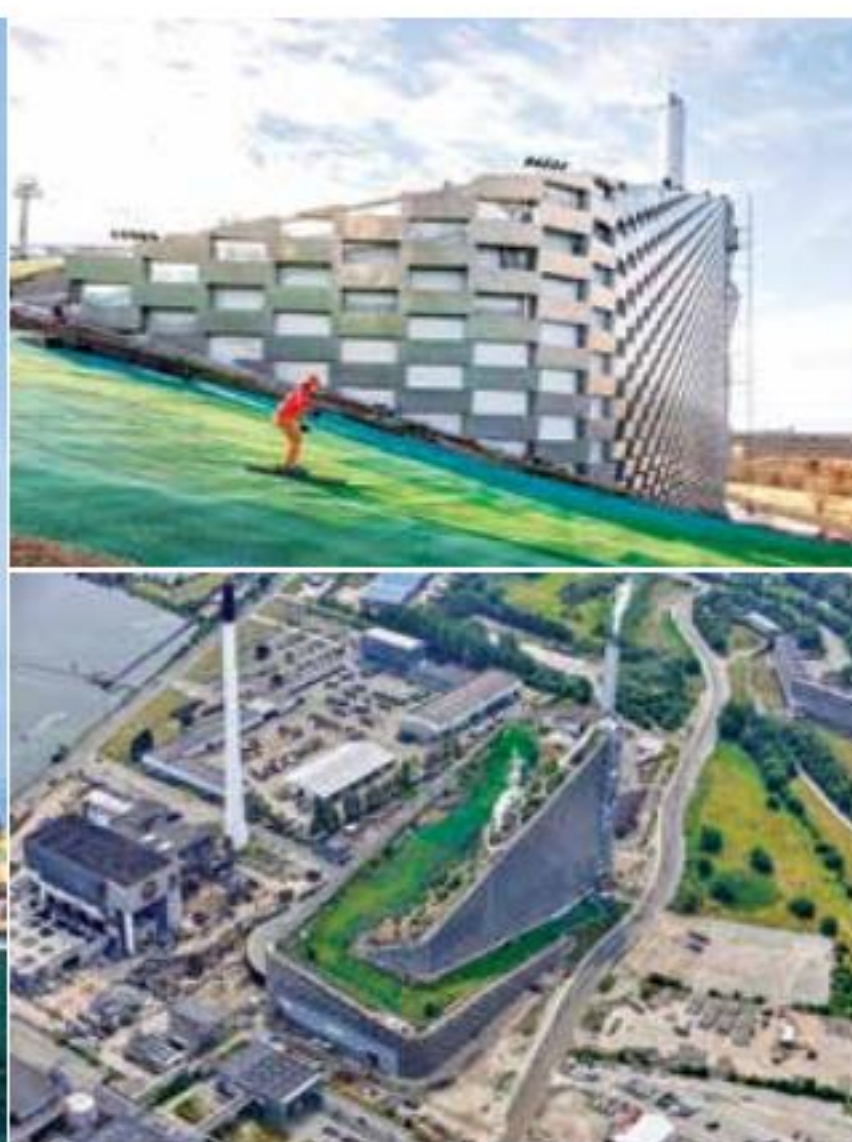
Nhà máy năng lượng xanh Copenhill hay còn gọi là Amager Bakke tọa lạc ở ngoại ô Đan Mạch được thiết kế bởi kiến trúc sư Bjarke Ingels. Nhà máy này có khả năng xử lý khối rác thải đến từ 600.000 hộ gia đình và 68.000 doanh nghiệp; rác được đốt để tạo ra điện năng và nhiệt năng cung cấp ngược về cho dân cư trong thành phố. Ngoài ra nhà máy này còn có chức năng tái chế một số loại rác thải khác. Đơn vị thiết kế đã đem đến nét thân thiện và vui vẻ cho khu nhà máy này bằng cách biến mái nhà trở thành một dốc trượt ván. Phần mái được phủ một lớp vật liệu màu xanh có tên neveblast và đem đến cảm giác như đang trượt trên tuyết. Thay vì phải đi xa 4-5 tiếng đến các khu trượt tuyết ở ngoại ô, giờ đây người dân Copenhagen có thể tận hưởng niềm vui ngay trên nhà máy năng lượng xanh của họ. Ảnh: Dragoer Luftfoto
