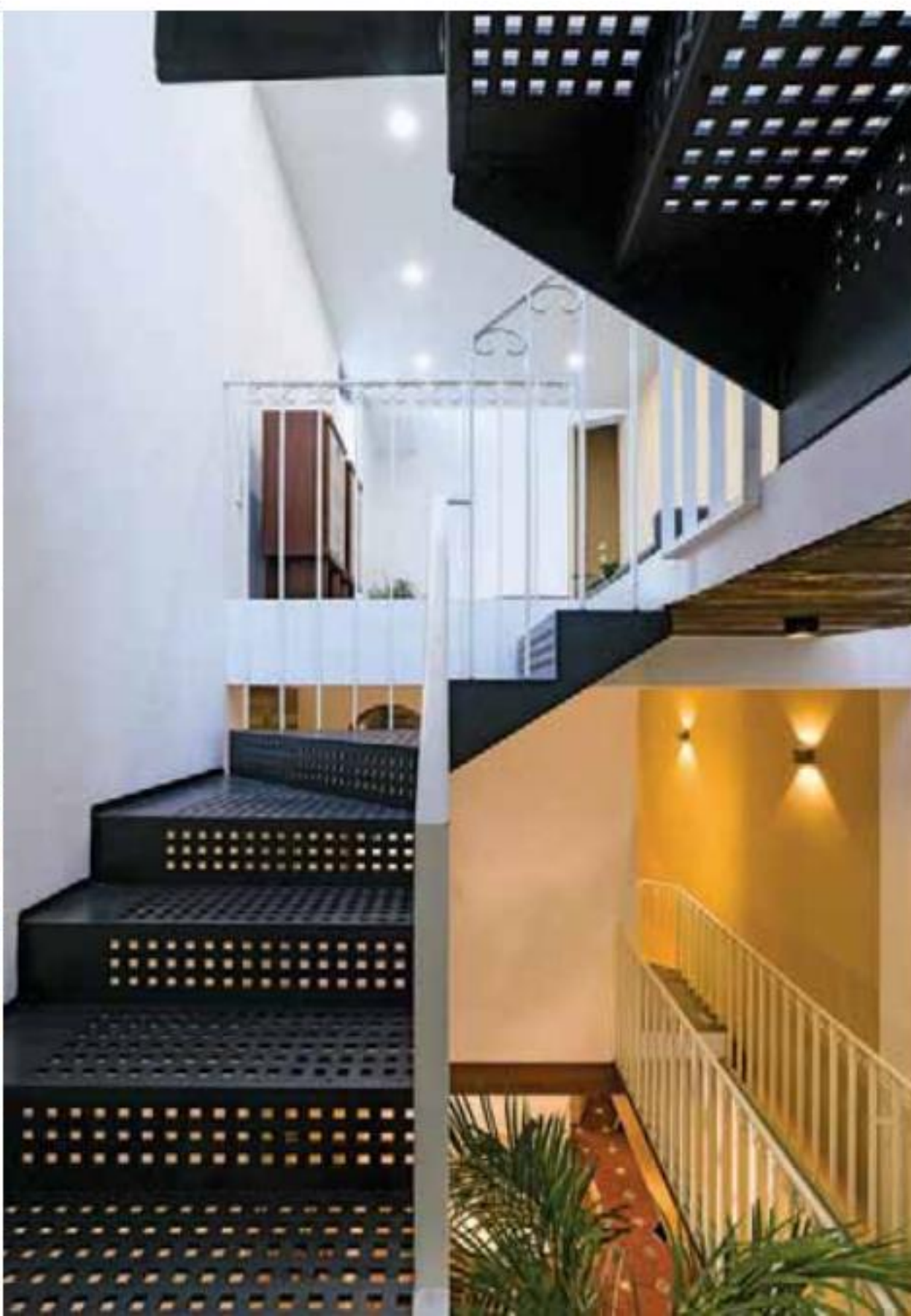
Thân thang, mặt bậc sử dụng vật liệu có khả năng xuyên sáng một phần, cho phép ánh sáng len lỏi, tạo ra hiệu ứng bóng đổ lên những bề mặt xung quanh.
