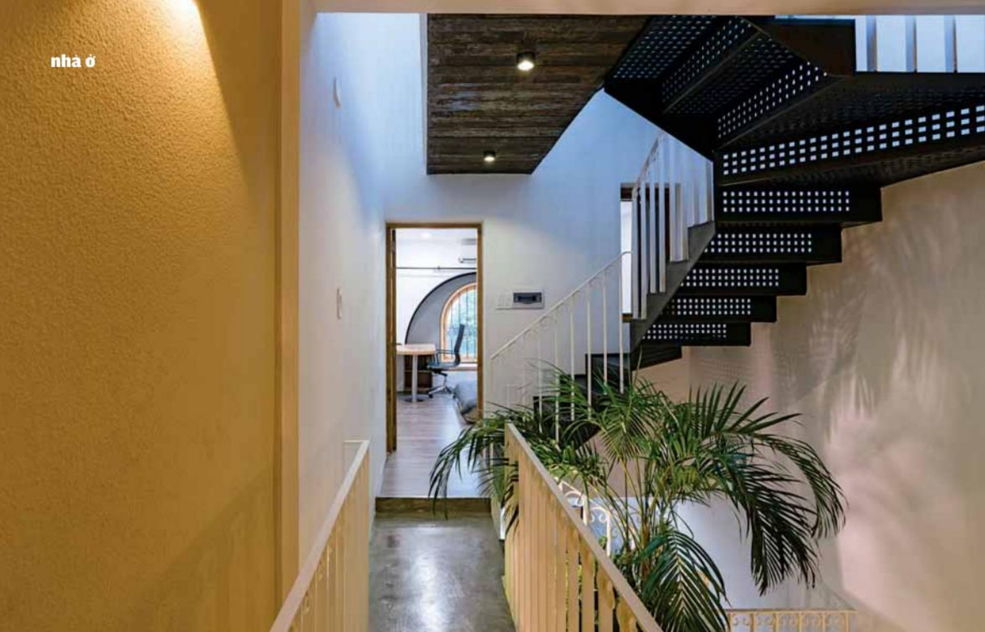
Thân thang, mặt bậc sử dụng vật liệu có khả năng xuyên sáng một phần, cho phép ánh sáng len lỏi, tạo ra hiệu ứng bóng đổ lên những bề mặt xung quanh.
