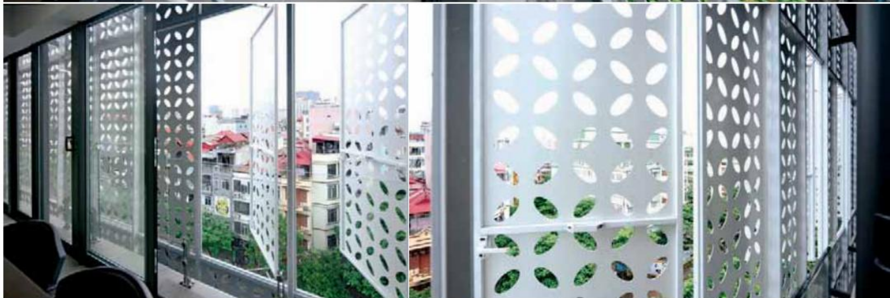
Hệ vách kính sau lớp mặt dựng được mở rộng hoàn toàn từ trần xuống đến sàn nhà để tối đa ánh sáng vào không gian làm việc bên trong
