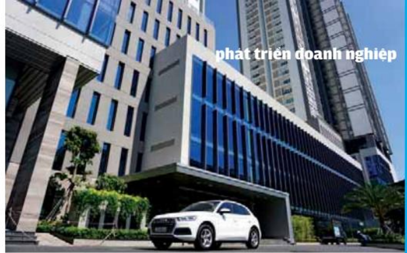
Công trình sử dụng kính Solar Control Viglacera
