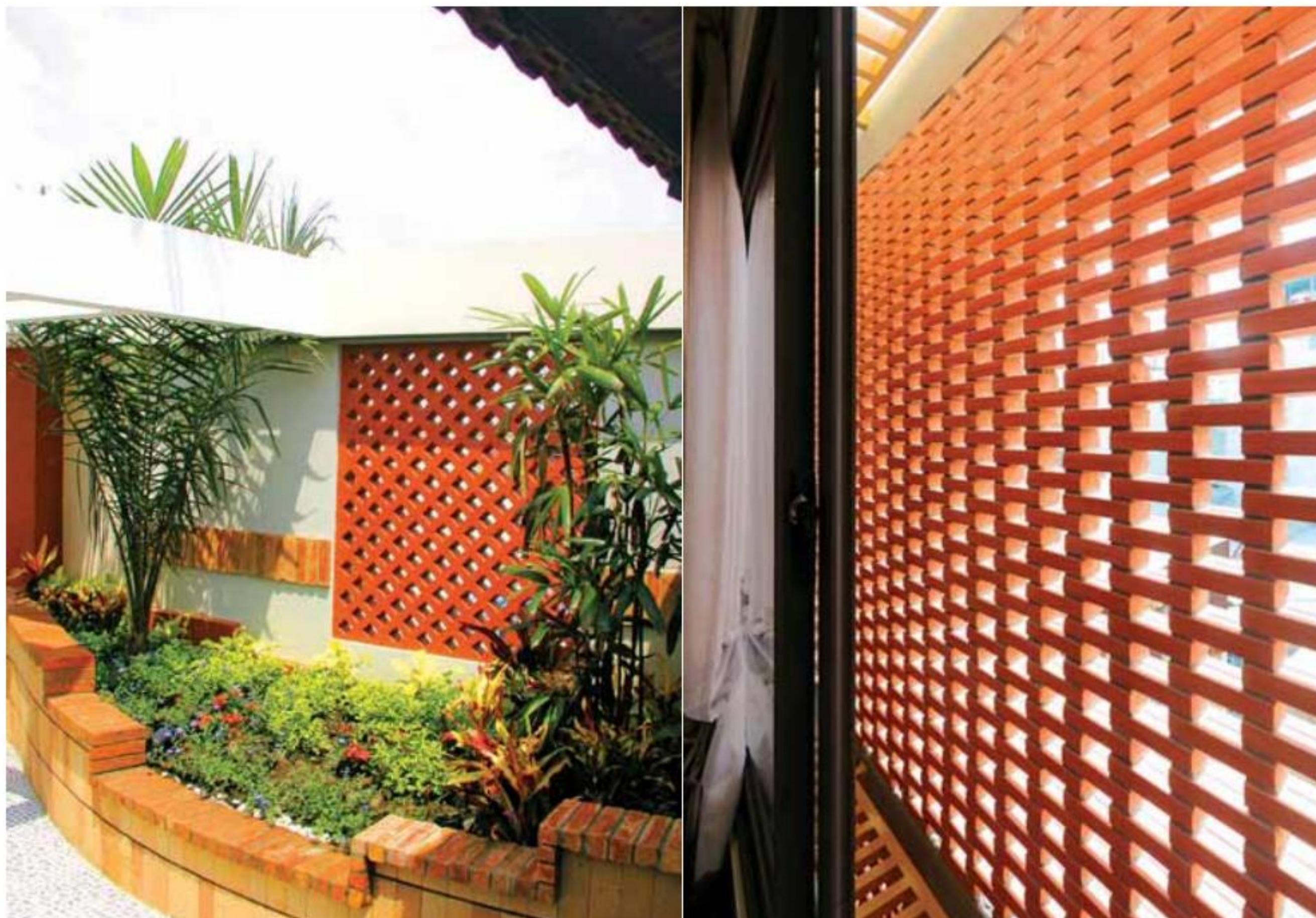
Ảnh trái Gạch trồng cỏ khi khéo phối kết cũng là một dạng bông gió hiệu quả Ảnh phải Với ngói cũ, gạch dính, bông gió nhiều loại... có thể phối kết thành mảng lớn cho các công trình showroom, resort, quán xá
