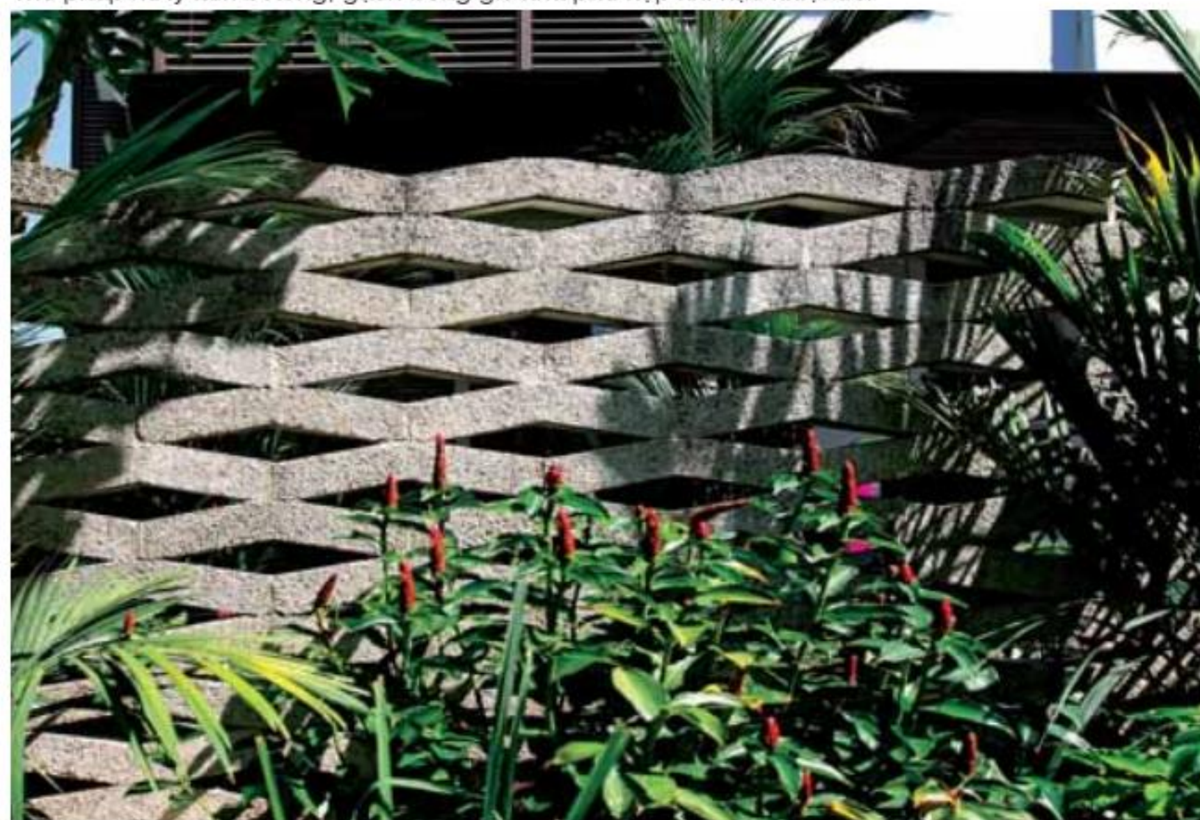
Thủ pháp xử lý lam bê tông, gạch bông gió khá phù hợp khí hậu nhiệt đới
