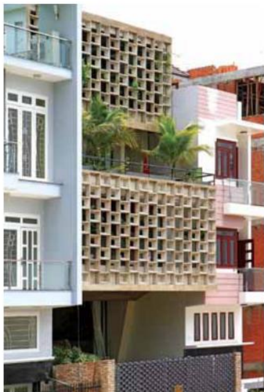
Hệ gạch bông gió có nhiều khả năng khai thác về tạo hình và che chắn cho nội ngoại thất nhà phố
