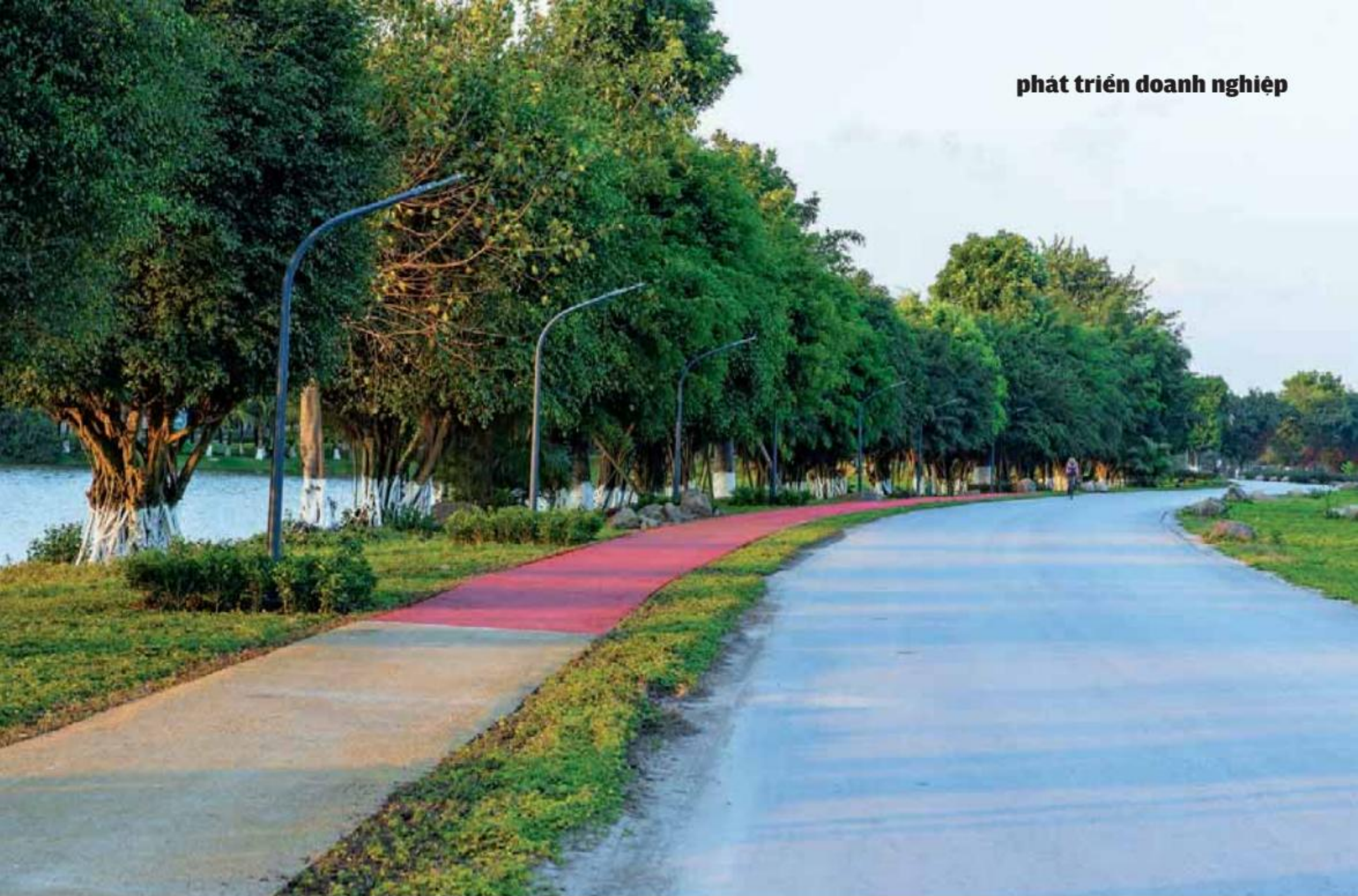
Đường đi bộ bằng bê tông tiêu thoát nước (INSEE Hydropave) của công viên sinh thái
