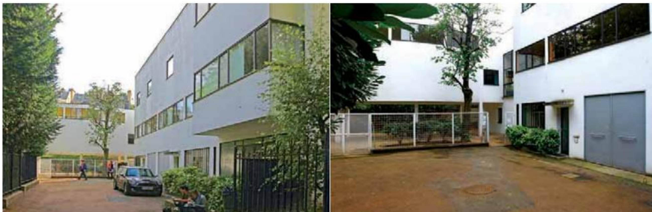
Ảnh trên Con phố nhỏ, lối vào nhỏ và ngôi nhà cũng nhỏ, nhưng không vì thế mà Le Corbusier và La Roche bị lãng quên ở thế kỷ 21
