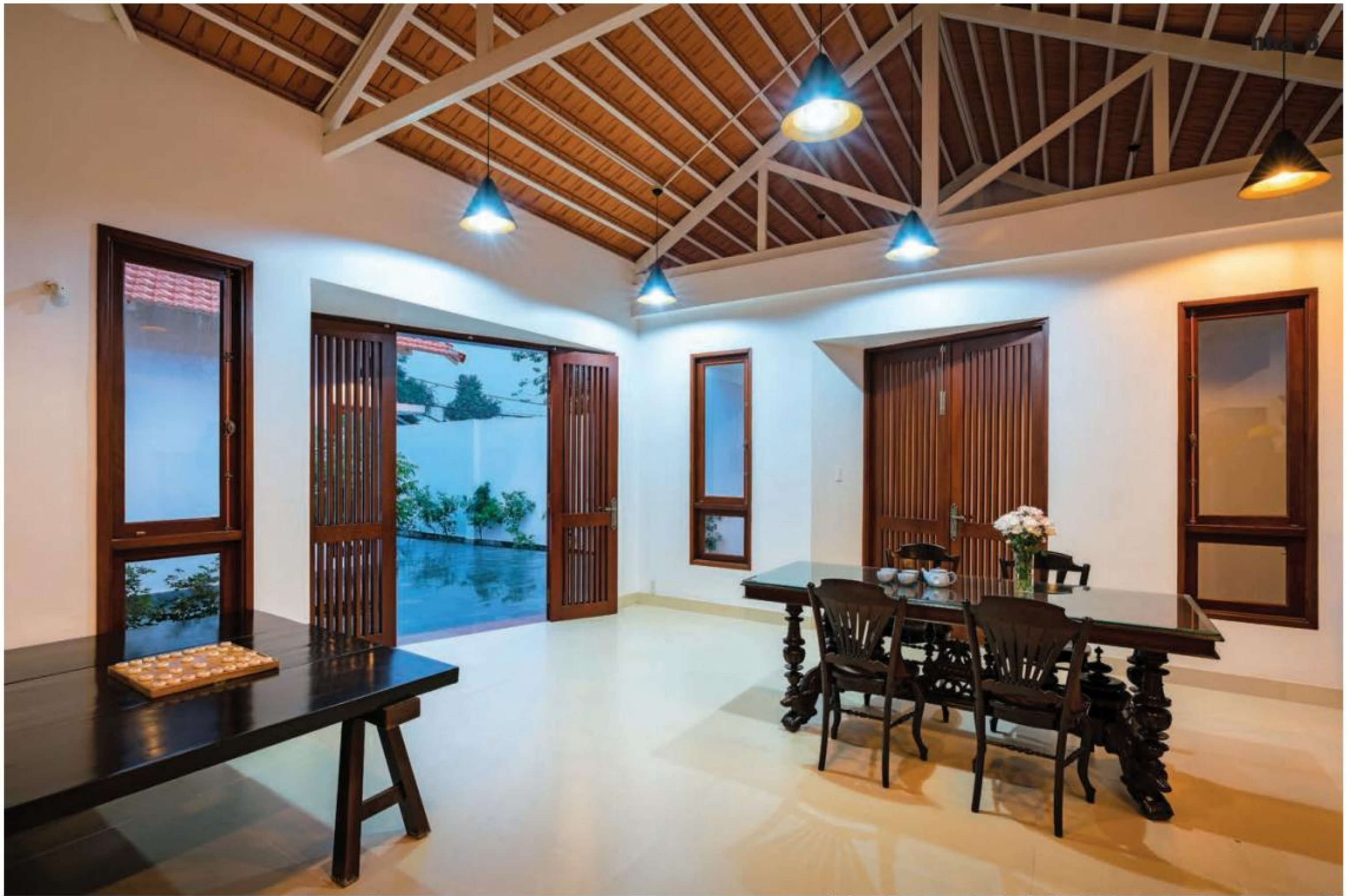
Ảnh hai trang Ngôi nhà có hệ kết cấu vĩ kèo thép hộp và ngói Đồng Nai. Những vật dụng trong nhà như bàn ăn, tủ thờ, sập gỗ có tuổi đời trên 50 năm do chính tay các thành viên trong gia đình gia công đều được giữ lại
