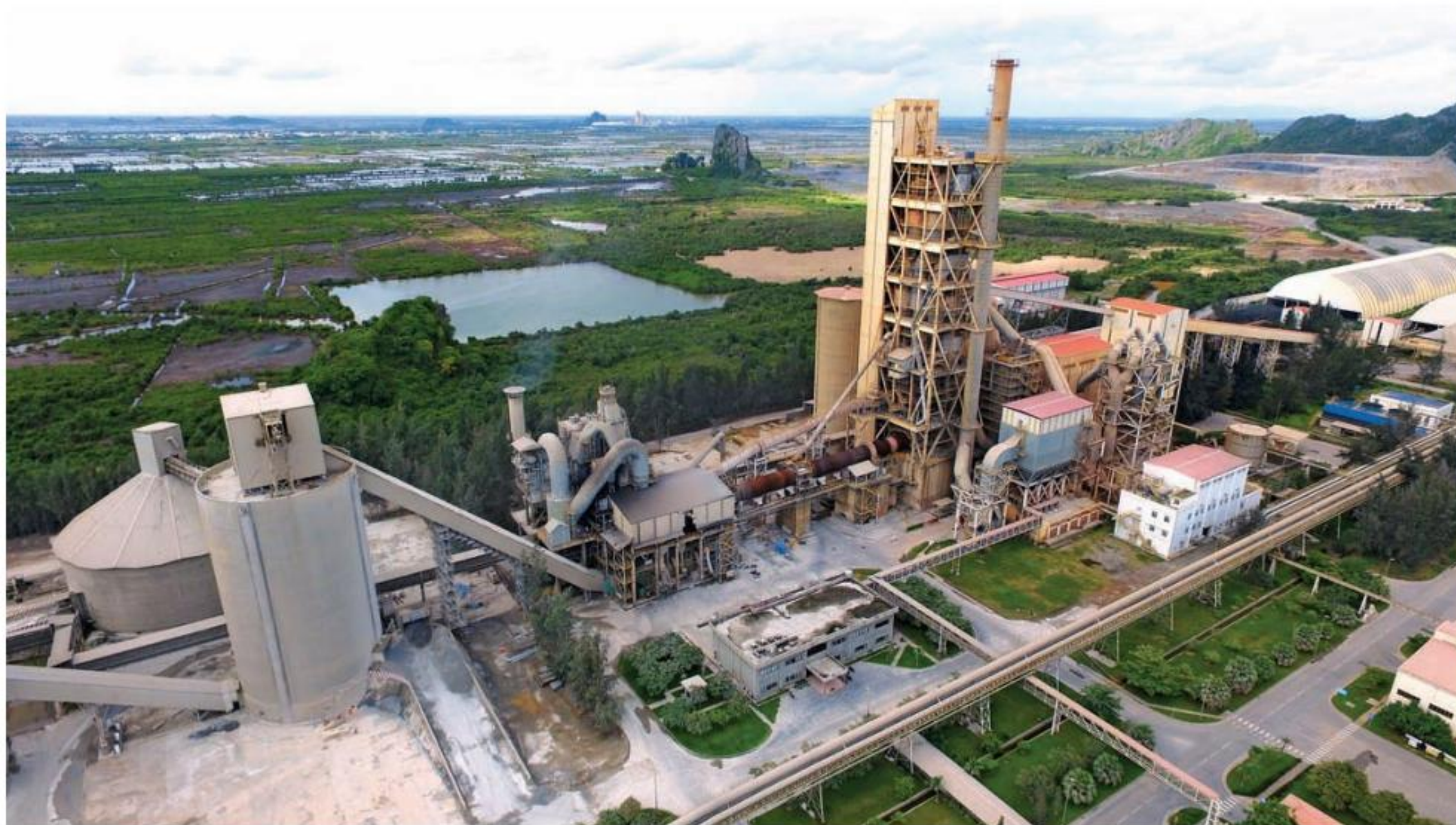
Toàn cảnh nhà máy xi măng INSEE tại Hòn Chông
