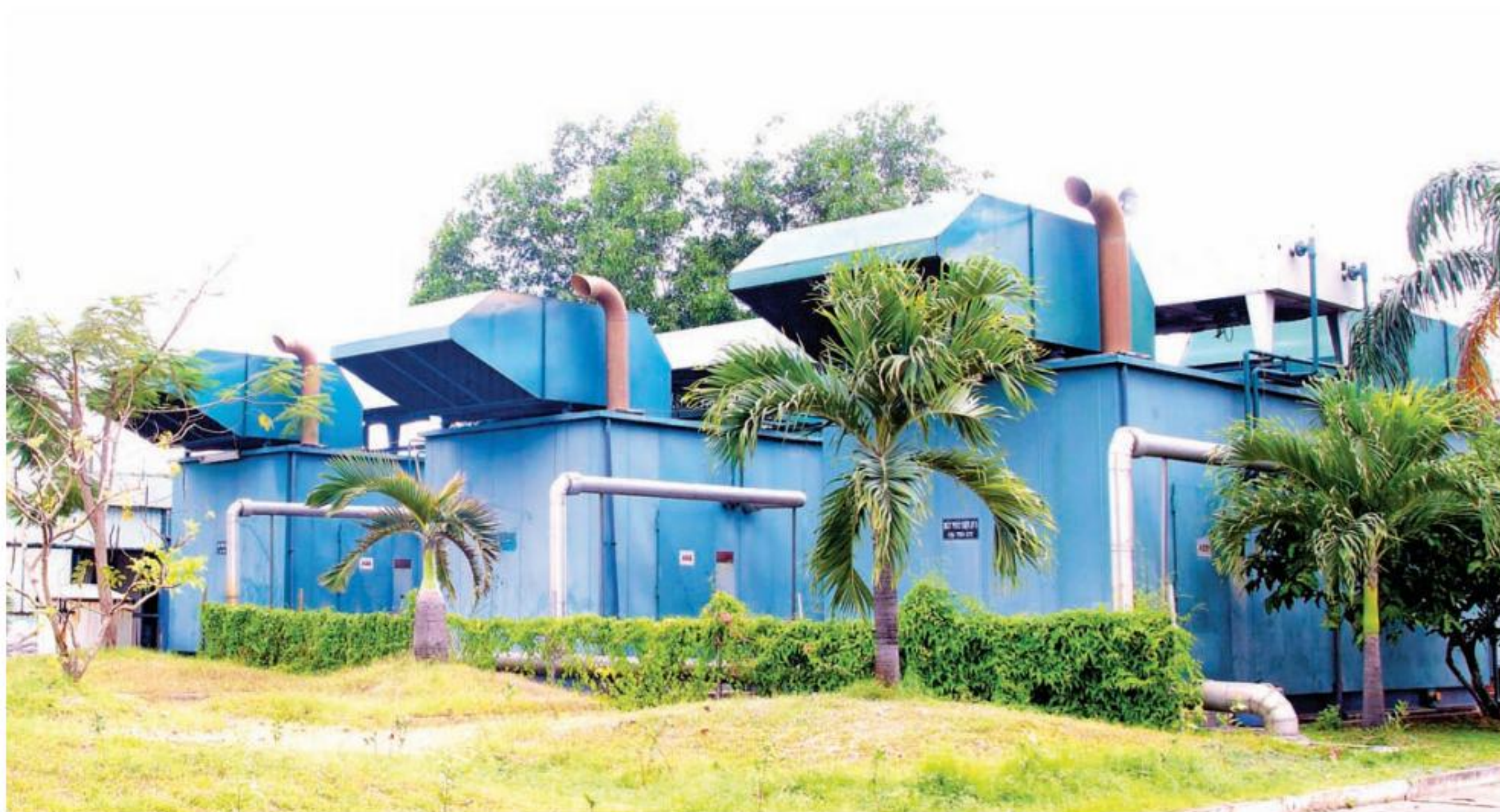
Nhà máy xử lý chất thải rắn với công nghệ đốt rác để phát điện ở Cần Thơ. Ảnh từ internet
