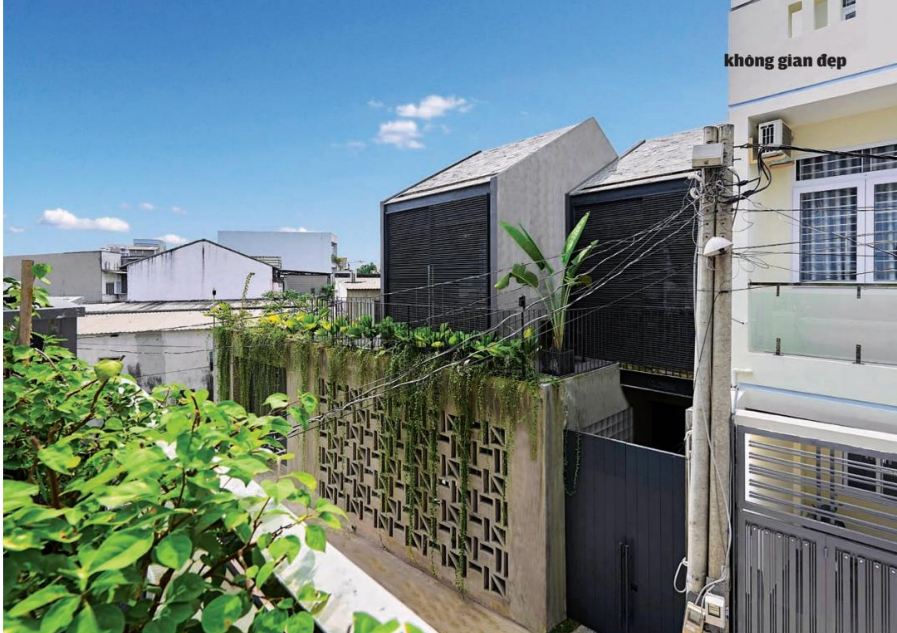
Ảnh trên và dưới Mặt tiền và mặt hông ngôi nhà. Toàn bộ mặt ngoài công trình hoàn thiện bằng vữa xi măng phủ sika chống thấm trộn xi măng bột
