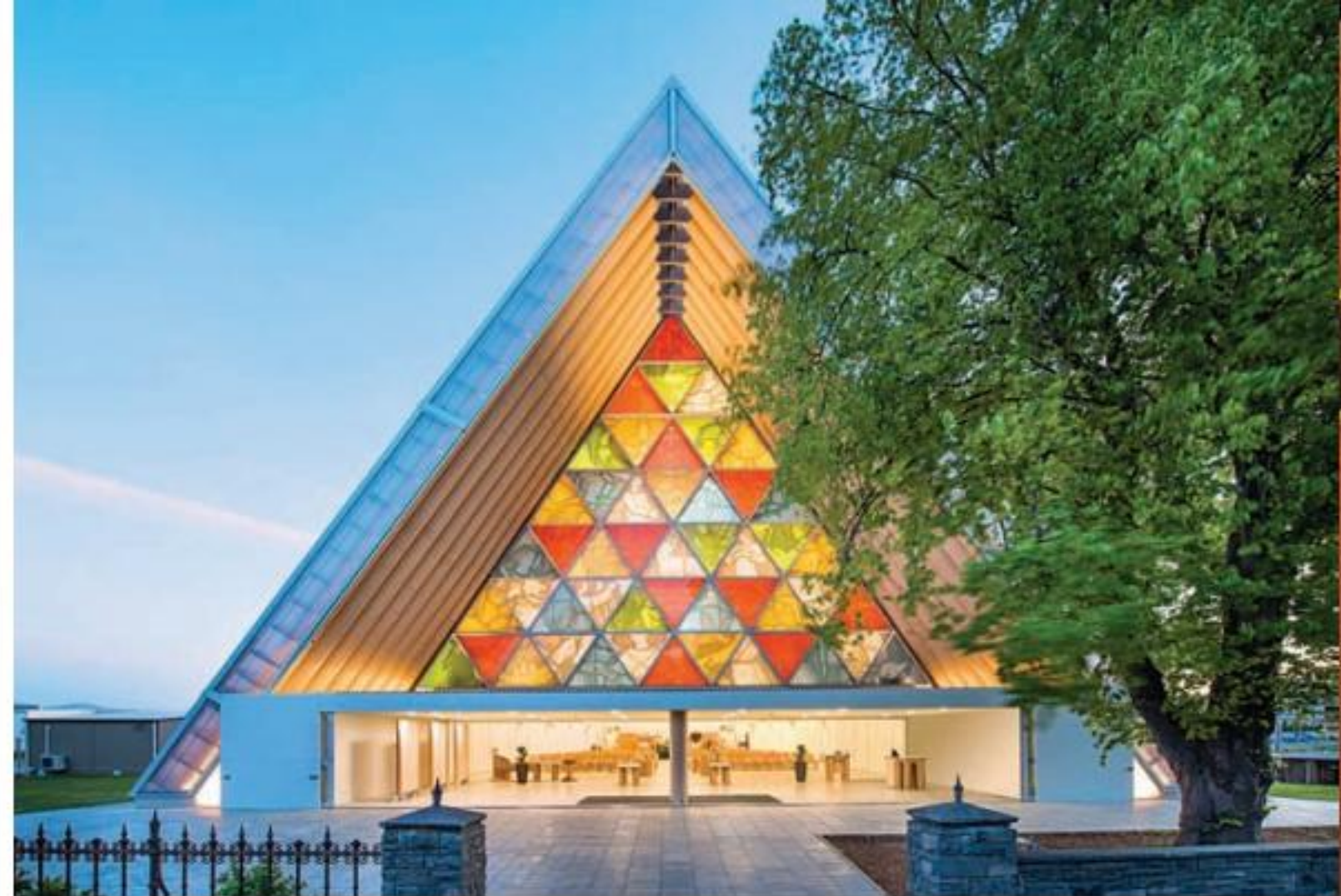
Ảnh bên trái Trường đại học Thiết kế Tự nhiên UC Berkeley với cấu tạo hoàn toàn từ gỗ ứng dụng kỹ thuật mộc ghép nổi cực nổi trội của Nhật Bản. Ảnh: © Shinken-chiku-sha Ảnh trên phải Nhà thờ Christchurch, New Zealand, 2013. Công trình đã được Shigeru Ban tái tạo lại bằng cách sử dụng những ống giấy khổng lồ để ghép thành tường và mái Ảnh dưới phải Centre de Santé et de Promotion Sociale cũng được xây dựng từ gỗ và đất sét. Nơi đây có các cửa sổ hình vuông được lấy cảm hứng từ những khung tranh, mỗi ô lại tập trung điểm nhìn vào từng khung cảnh khác biệt. Ảnh: kere-architecture.com
