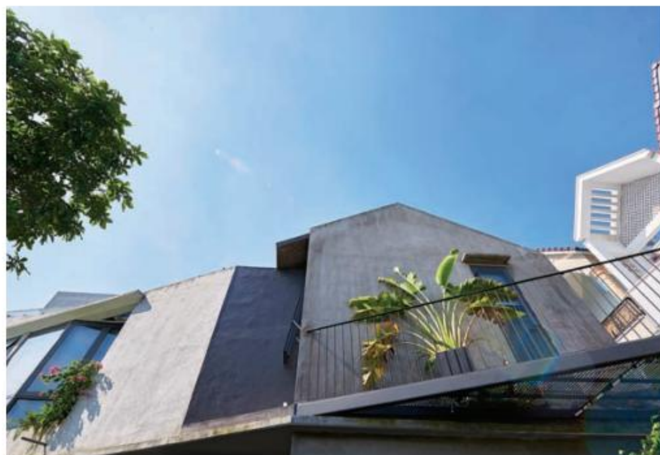
Ảnh trên và dưới Mặt tiền và mặt hông ngôi nhà. Toàn bộ mặt ngoài công trình hoàn thiện bằng vữa xi măng phủ sika chống thấm trộn xi măng bột
