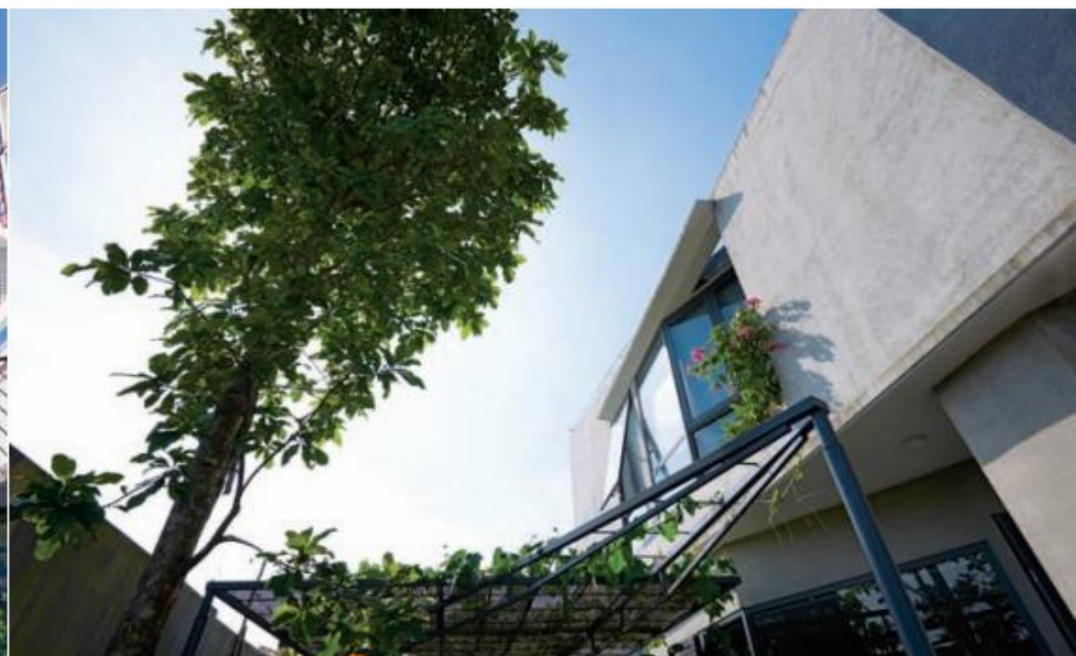
Ảnh trên và dưới Mặt tiền và mặt hông ngôi nhà. Toàn bộ mặt ngoài công trình hoàn thiện bằng vữa xi măng phủ sika chống thấm trộn xi măng bột
