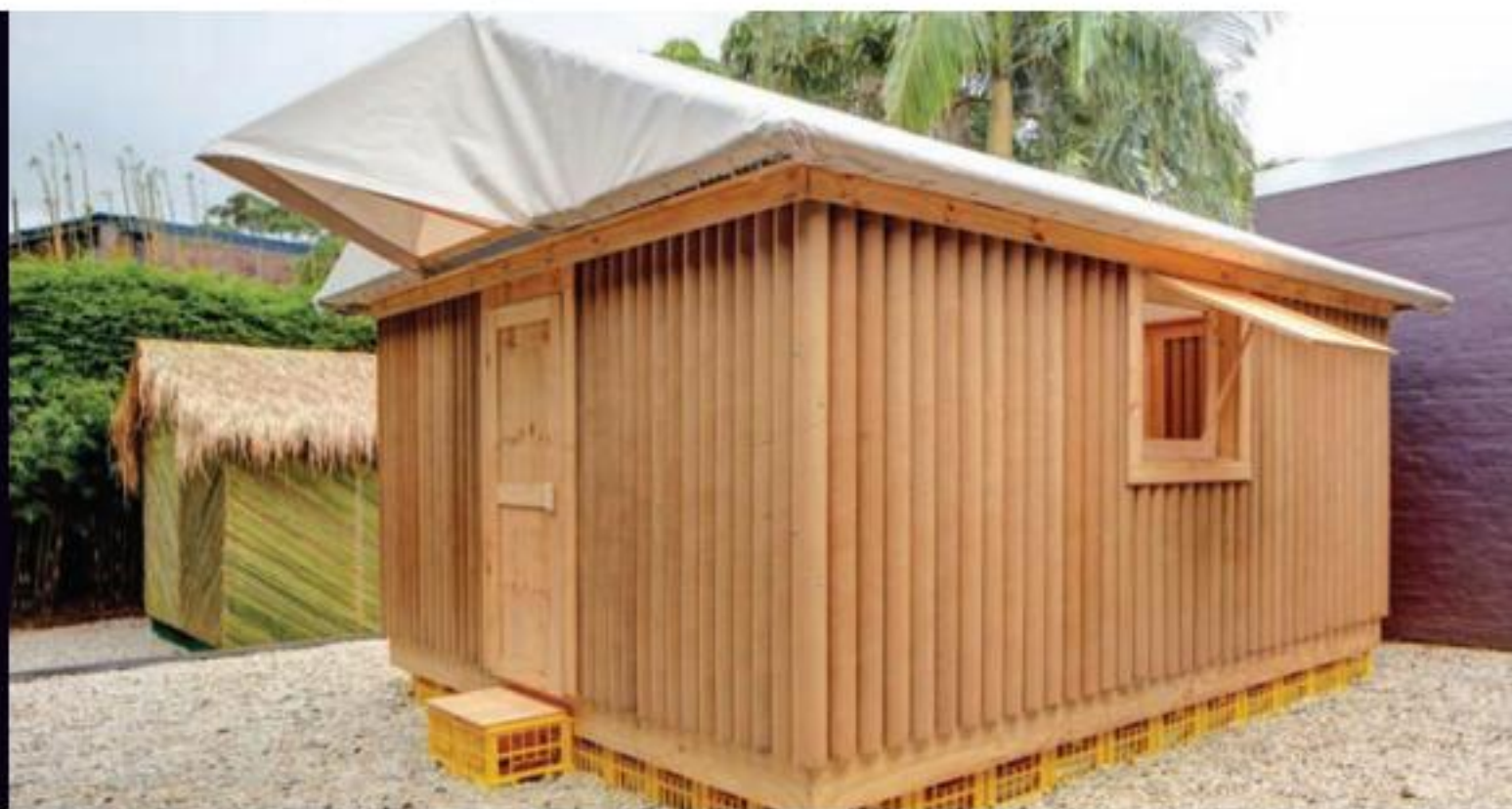
Nhà Paper Log - Kobe, Nhật Bản, 1995 Ngôi nhà cứu trợ này có phần để được tạo thành từ những kết bìa chứa đầy những bao tải cát. Tường được ghép từ những ống giấy dài 106mm, dày 4mm và mái được căng phủ loại vải lều. Để cách nhiệt, một lớp keo cường lực chống thấm được dán kẹp vào giữa các ống trên tường. Một căn nhà 52m 2 này chỉ tốn chưa đến 2.000 USD và dễ dàng tháo gỡ, tái chế cũng như phân hủy
