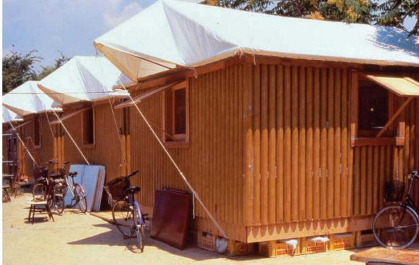
Nhà Paper Log - Kobe, Nhật Bản, 1995 Ngôi nhà cứu trợ này có phần để được tạo thành từ những kết bìa chứa đầy những bao tải cát. Tường được ghép từ những ống giấy dài 106mm, dày 4mm và mái được căng phủ loại vải lều. Để cách nhiệt, một lớp keo cường lực chống thấm được dán kẹp vào giữa các ống trên tường. Một căn nhà 52m 2 này chỉ tốn chưa đến 2.000 USD và dễ dàng tháo gỡ, tái chế cũng như phân hủy
