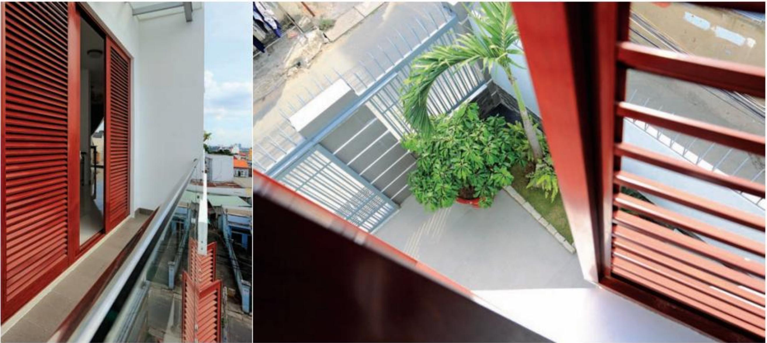
Ảnh trên Hệ cửa lùa, cửa xoay bằng lam nhôm giả gỗ đặt tại các vị trí cản che chắn nắng gắt Ảnh dưới trái Không gian cầu thang kết hợp giếng trời, hành lang có lam che nắng là trục kết nối toàn nhà Ảnh dưới phải Phòng ngủ của cha mẹ có khoảng đệm giảm nắng bọc bên ngoài
