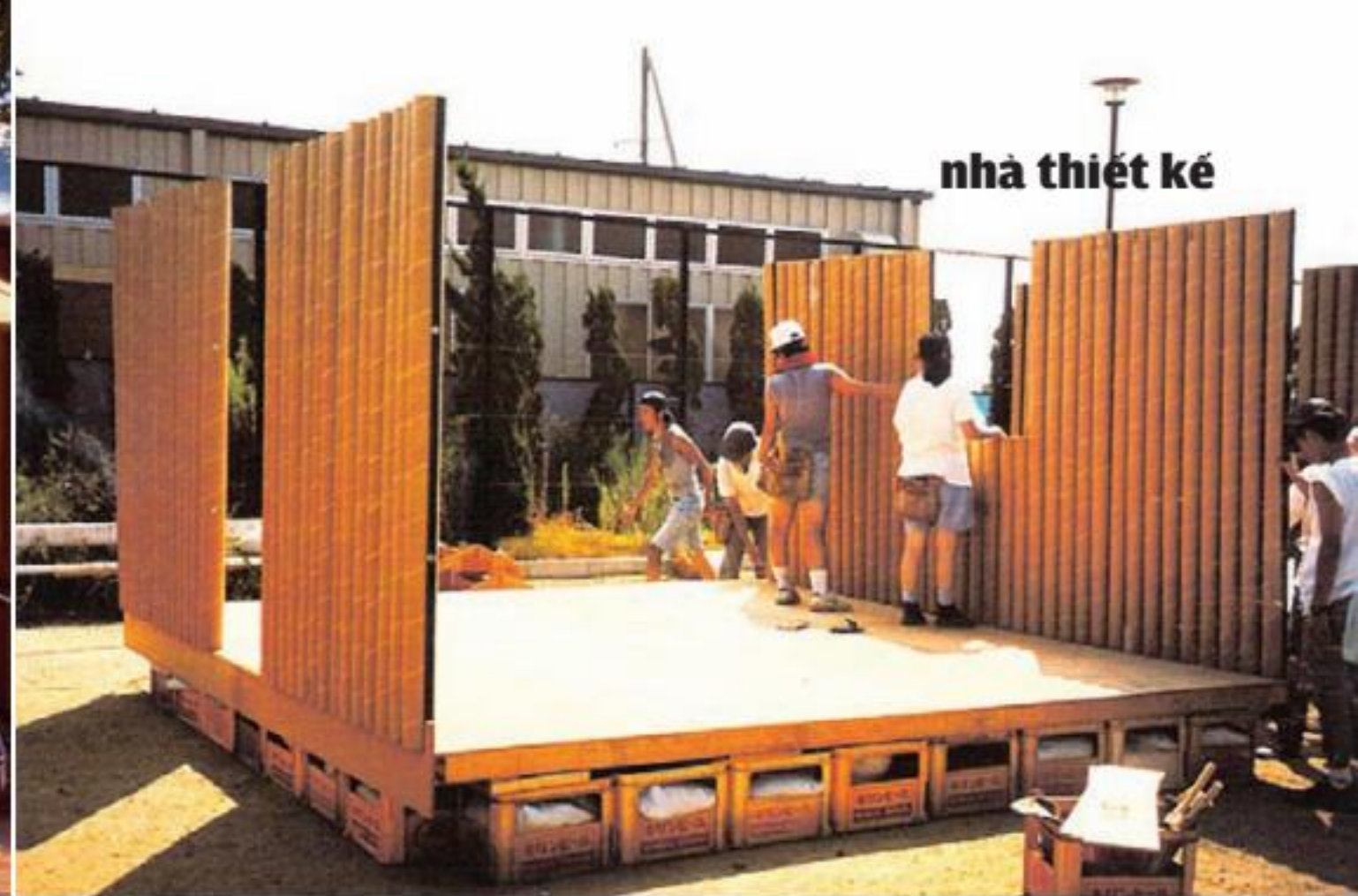
Nhà Paper Log - Kobe, Nhật Bản, 1995 Ngôi nhà cứu trợ này có phần để được tạo thành từ những kết bìa chứa đầy những bao tải cát. Tường được ghép từ những ống giấy dài 106mm, dày 4mm và mái được căng phủ loại vải lều. Để cách nhiệt, một lớp keo cường lực chống thấm được dán kẹp vào giữa các ống trên tường. Một căn nhà 52m 2 này chỉ tốn chưa đến 2.000 USD và dễ dàng tháo gỡ, tái chế cũng như phân hủy
