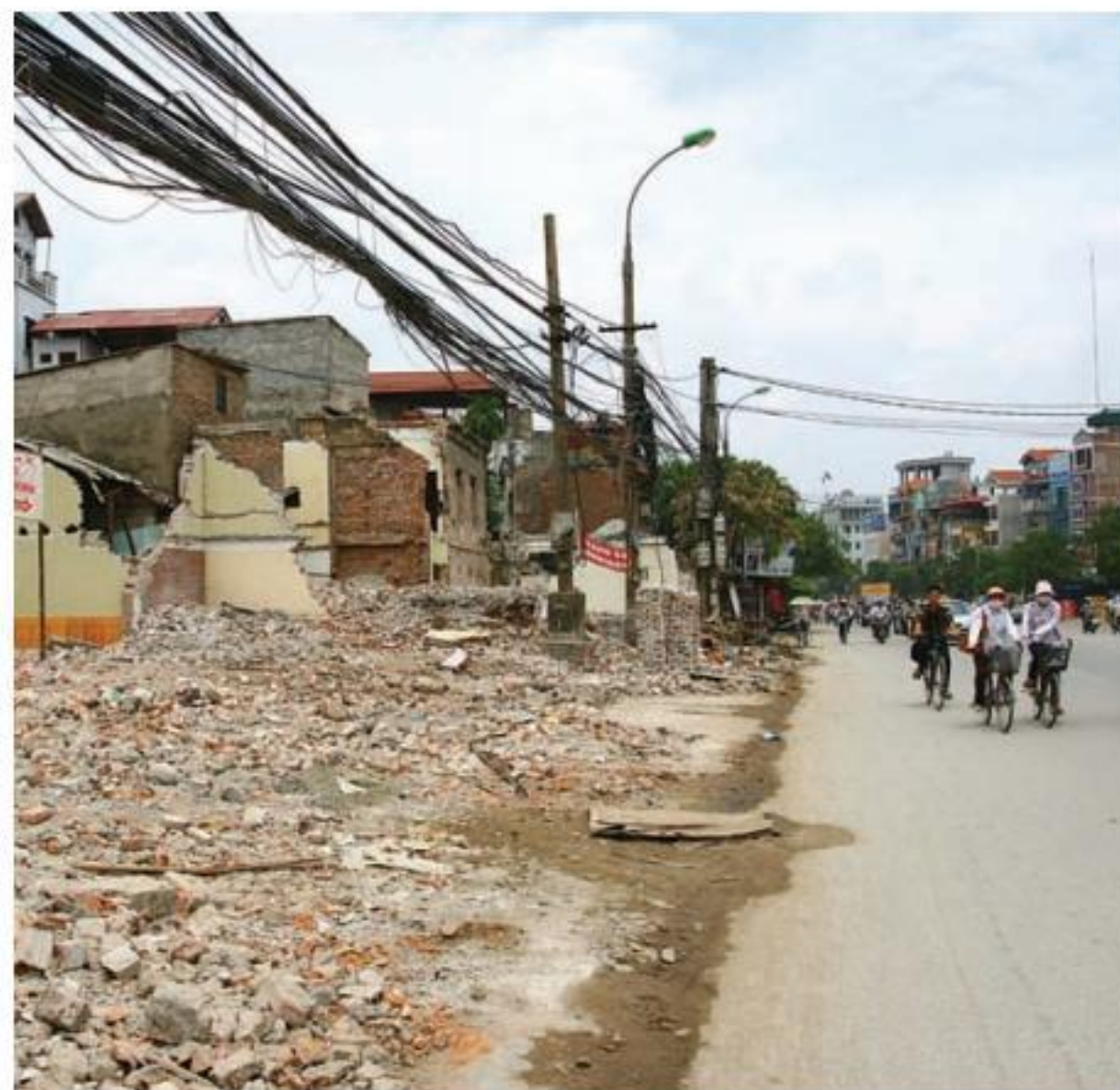
Ảnh trên và dưới Việc phá dỡ công trình, xây dựng hạ tầng thải một lượng lớn rác thải xây dựng và khối bụi vào môi trường
