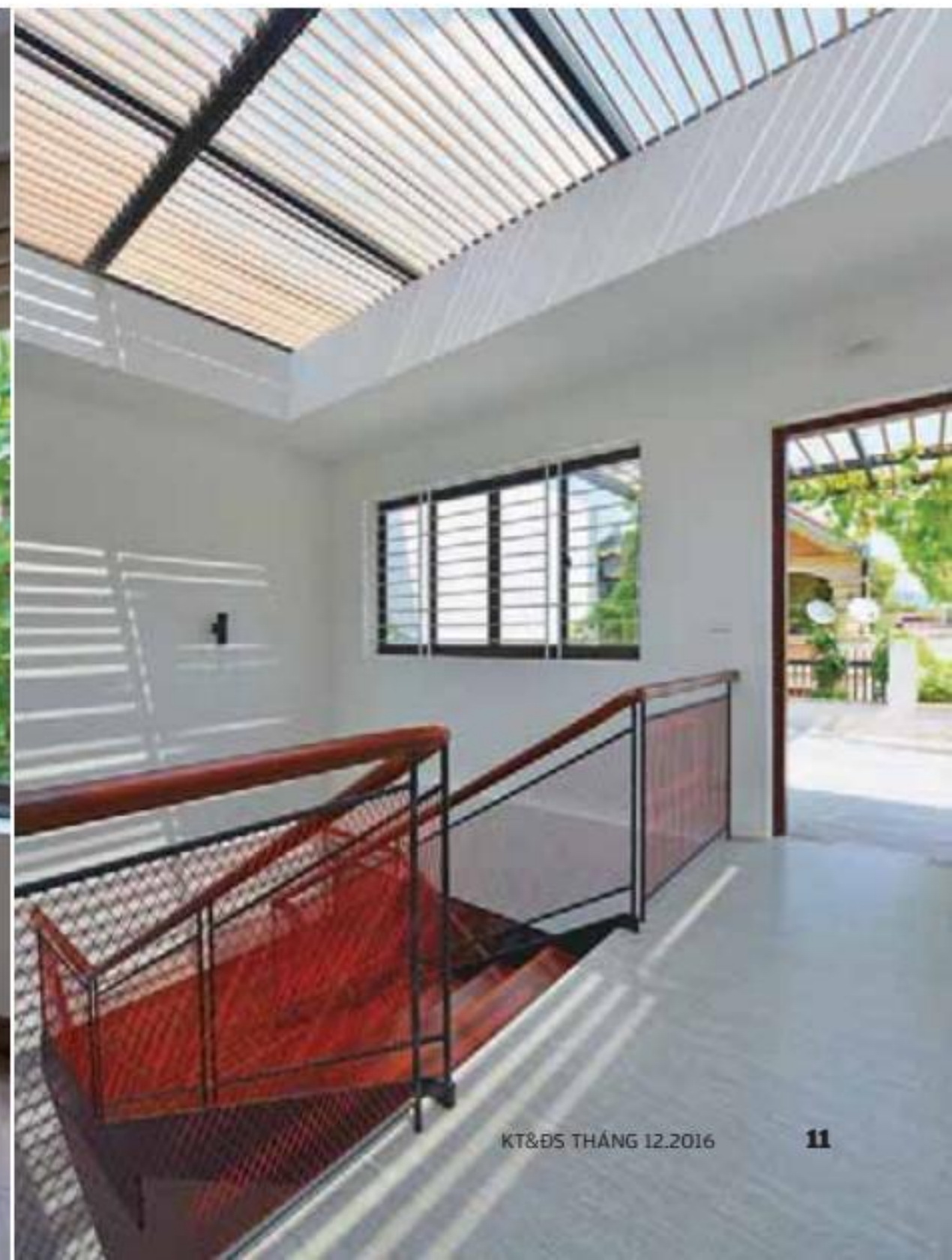
Ảnh hai trang Chất hiện đại trong sử dụng vật liệu và màu sắc để làm nên cầu thang. Thép đen sơn tĩnh điện nhấn bằng hệ lưới màu đỏ
