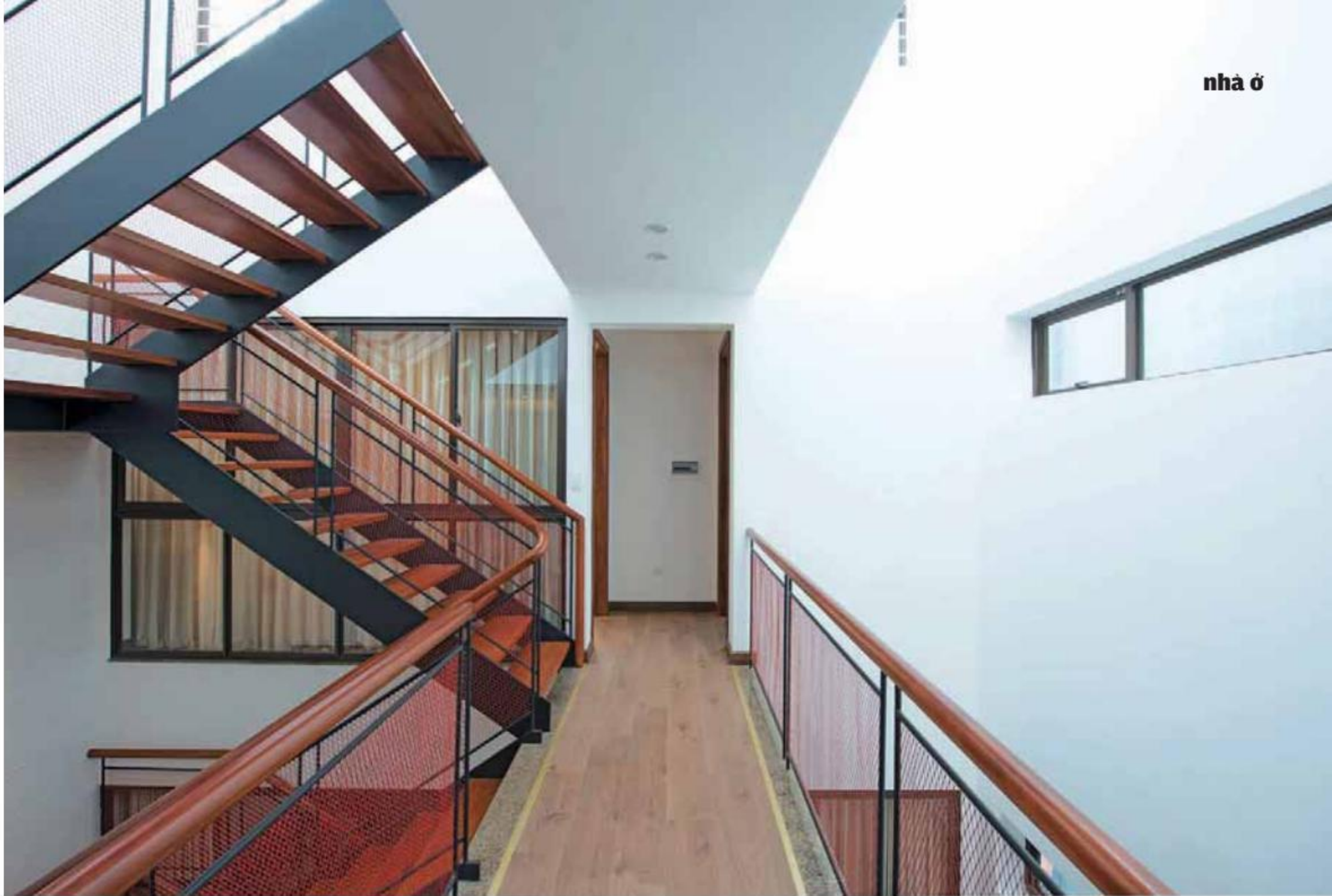
Ảnh hai trang Chất hiện đại trong sử dụng vật liệu và màu sắc để làm nên cầu thang. Thép đen sơn tĩnh điện nhấn bằng hệ lưới màu đỏ
