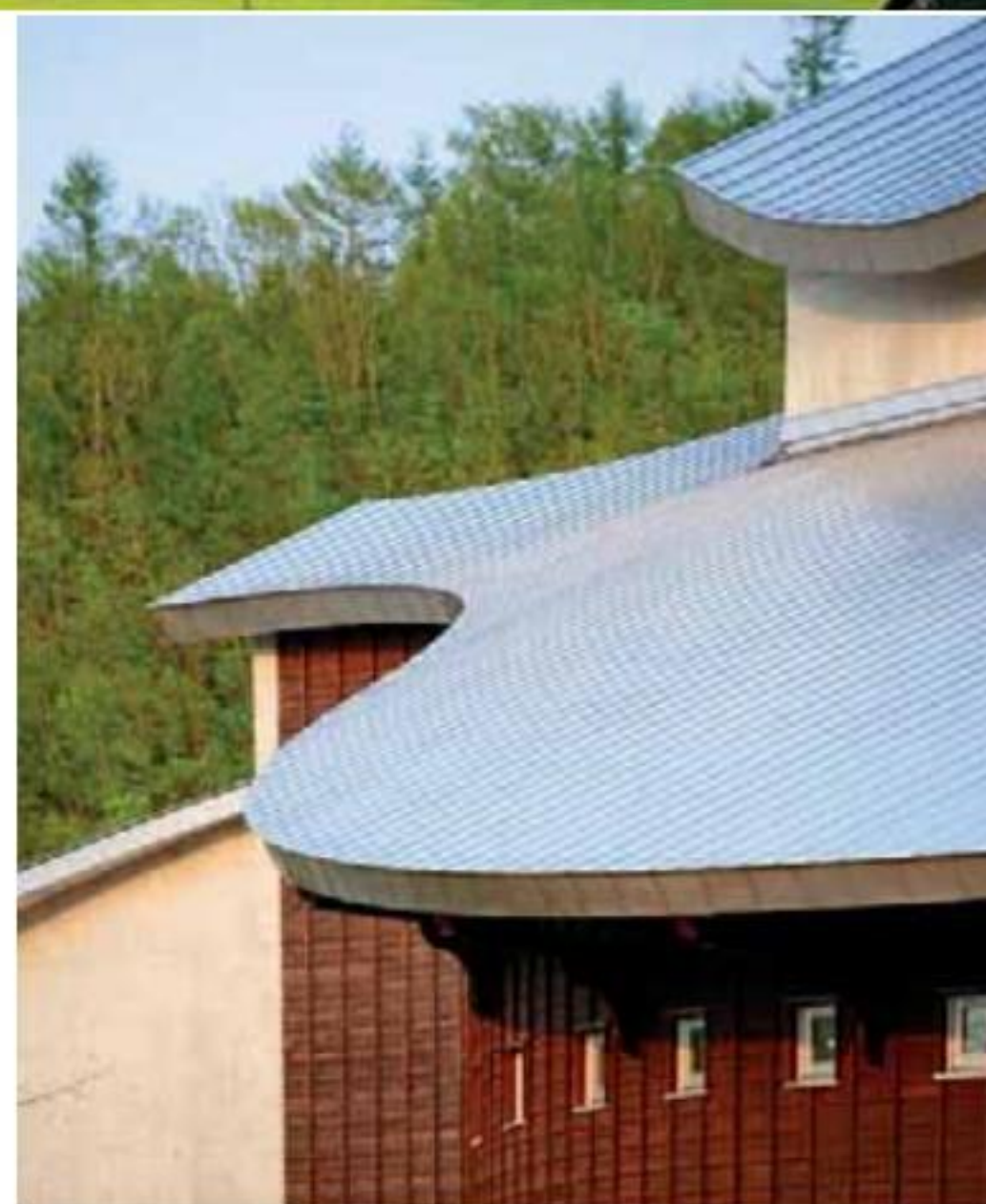
Ảnh trên Mặt sau của bảo tàng là một kết cấu đối xứng với hệ mái chồng phức tạp lên nhau Ảnh dưới Lớp mái chính làm từ chất liệu nhôm màu sáng bạc, mang các đường gấp, nét cong cầu kỳ, cùng hệ trụ tháp làm điểm nhấn tạo bề thế cho lớp mái của bảo tàng thêm ấn tượng
