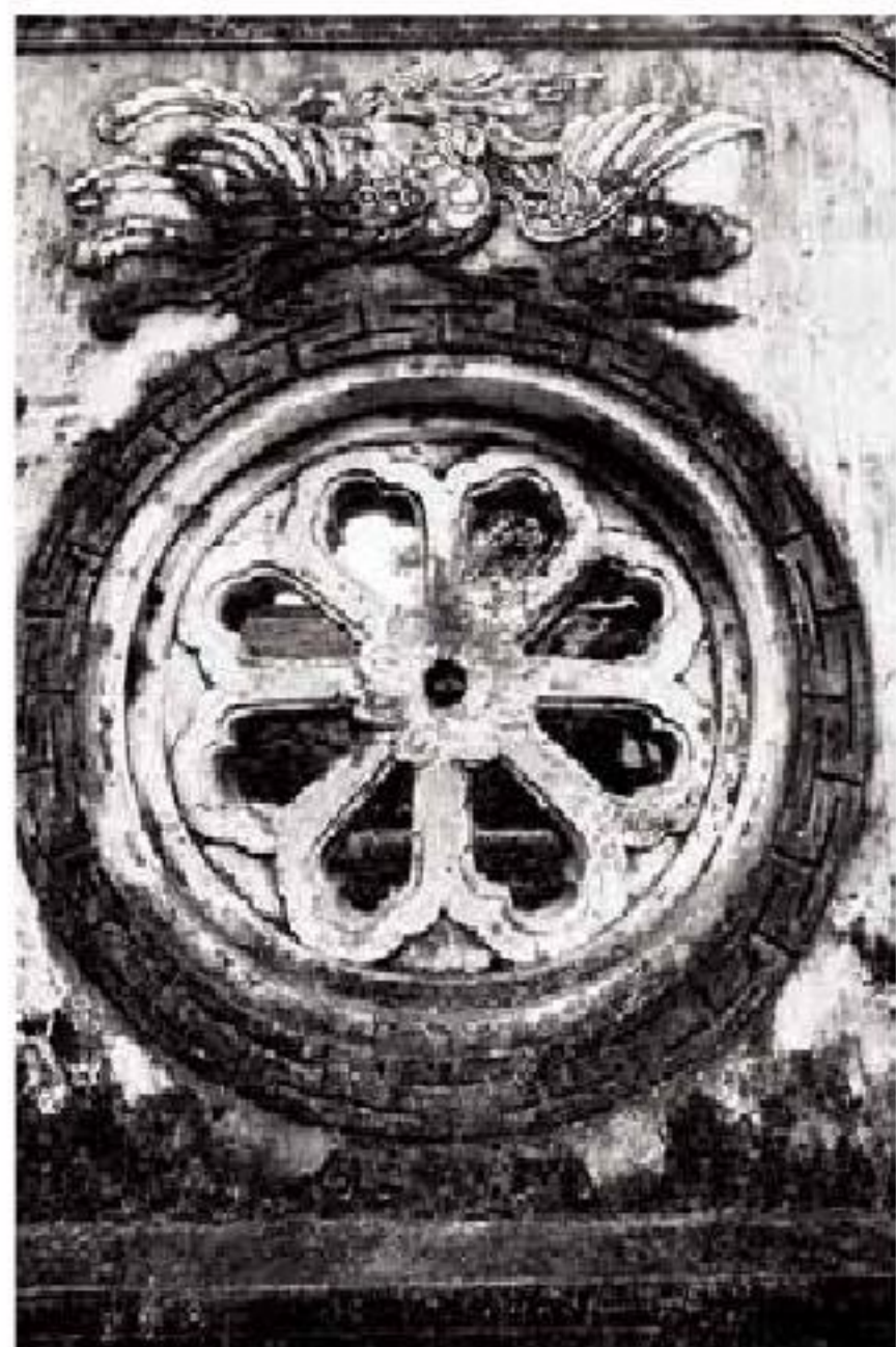
Bông gió trên tường rào, bình phong tại khu đền thờ vua Đinh, vua Lê (Hoa Lư, Ninh Bình)
