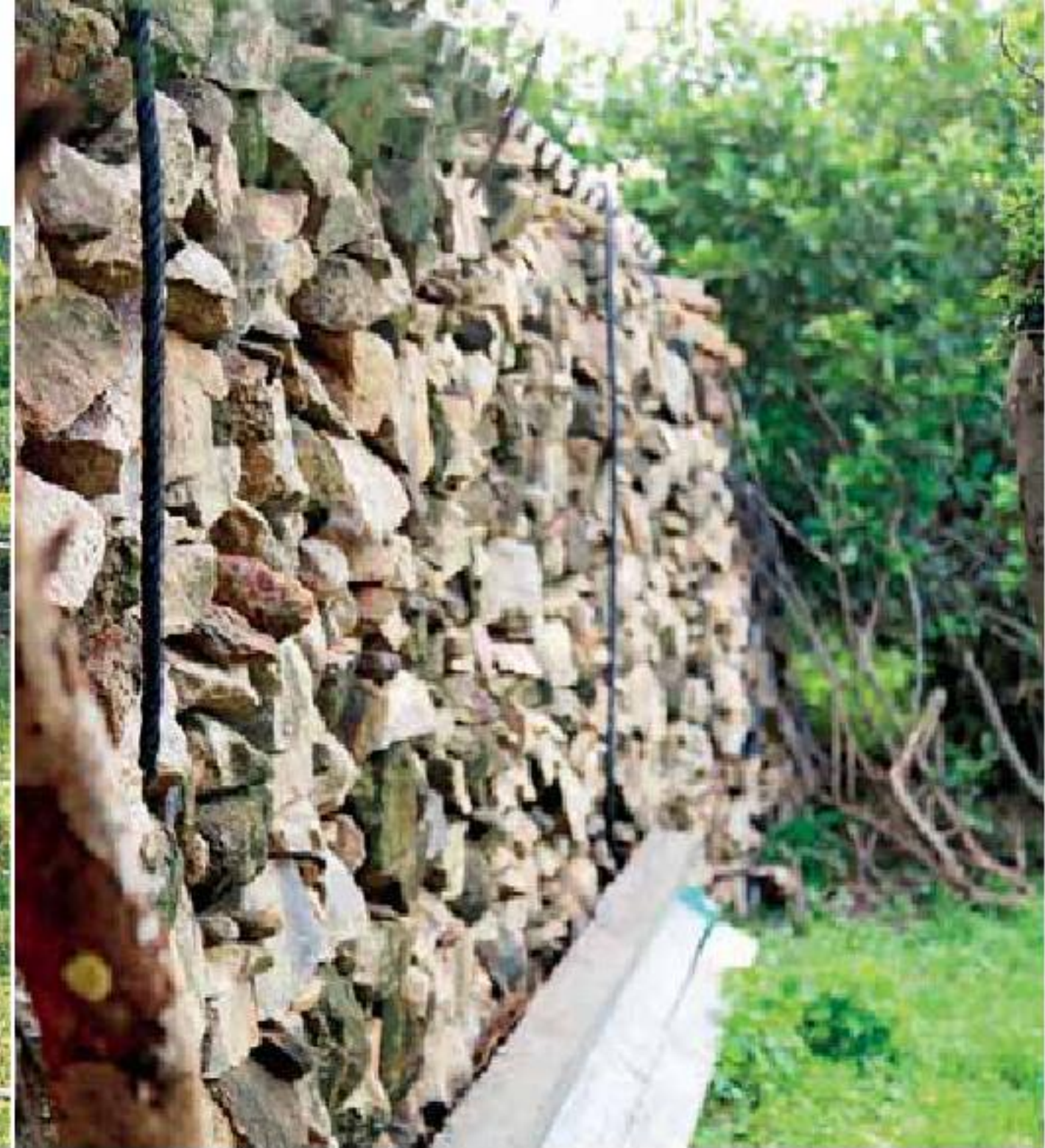
Ảnh trên và dưới Xếp đá làm tường bao, làm nhà nuôi gia súc vừa chống chịu được khắc nghiệt của nắng nóng mùa khô và gió chướng mùa mưa bão.
