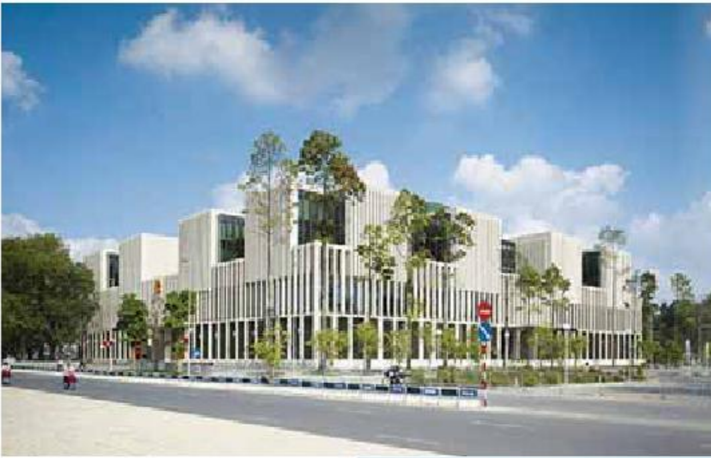
Công trình Nhà Quốc hội. Ảnh chụp thực tế công trình.
