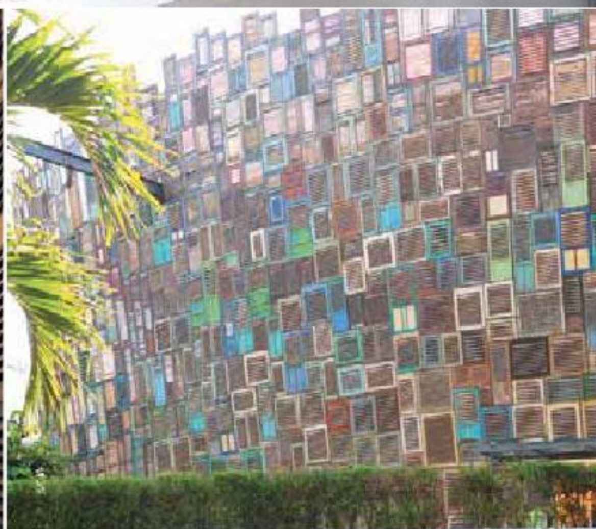
Ảnh trên và dưới Sự kết hợp hài hòa giữa cửa gỗ, khung kim loại chịu lực và lối đi được thiết kế mộc mạc, tạo cho Lilin một tổng thể giản đơn nhưng rất ấn tượng.
