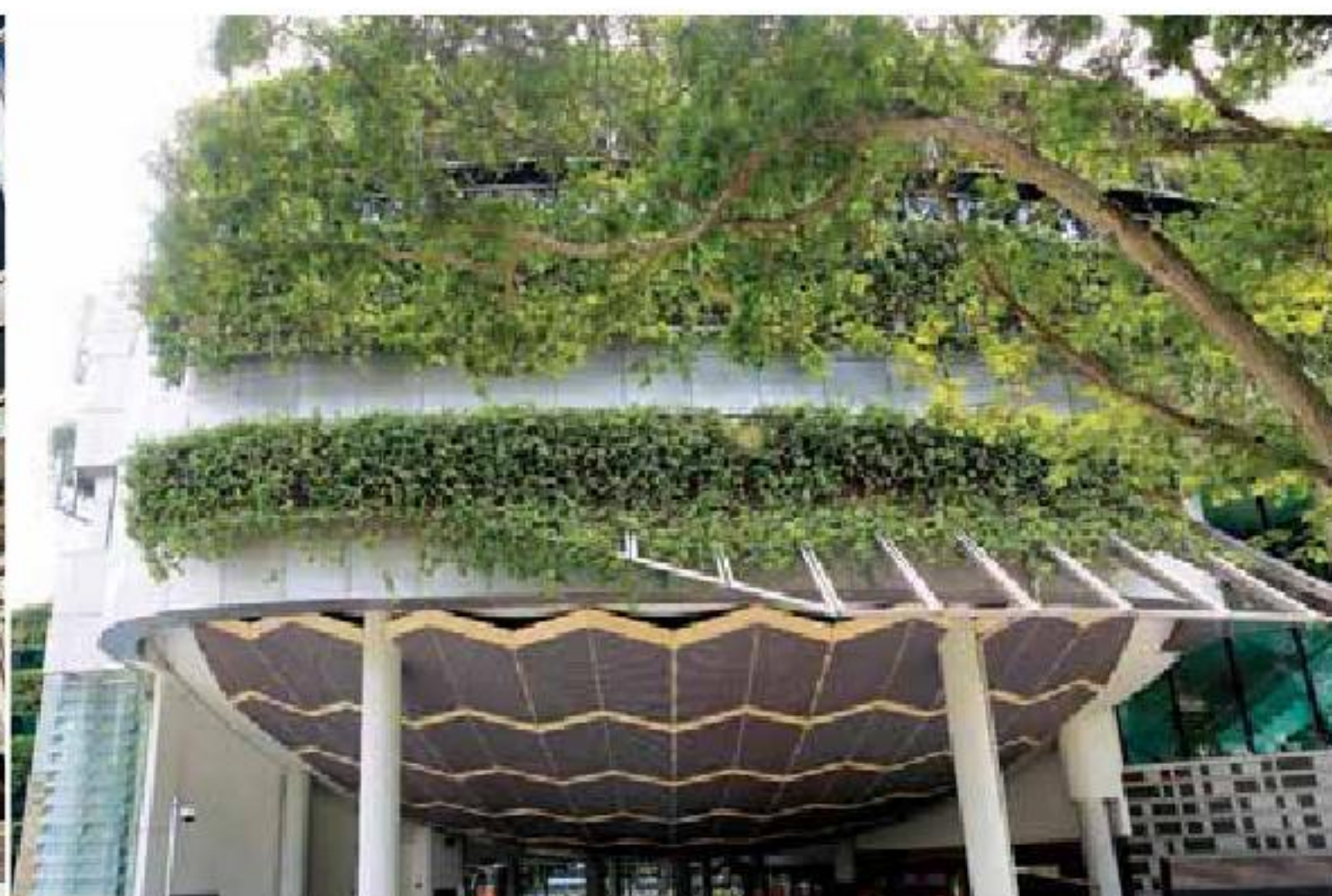
Ảnh trên Khai thác khả năng tạo hình và che chắn của lam nhôm hiện đại được nhiều nơi từ Singapore đến châu Âu ưa chuộng. Ảnh dưới Che nắng hướng tây với lam đứng kết hợp mái ngang và mảng đặc lớn khá phù hợp.
