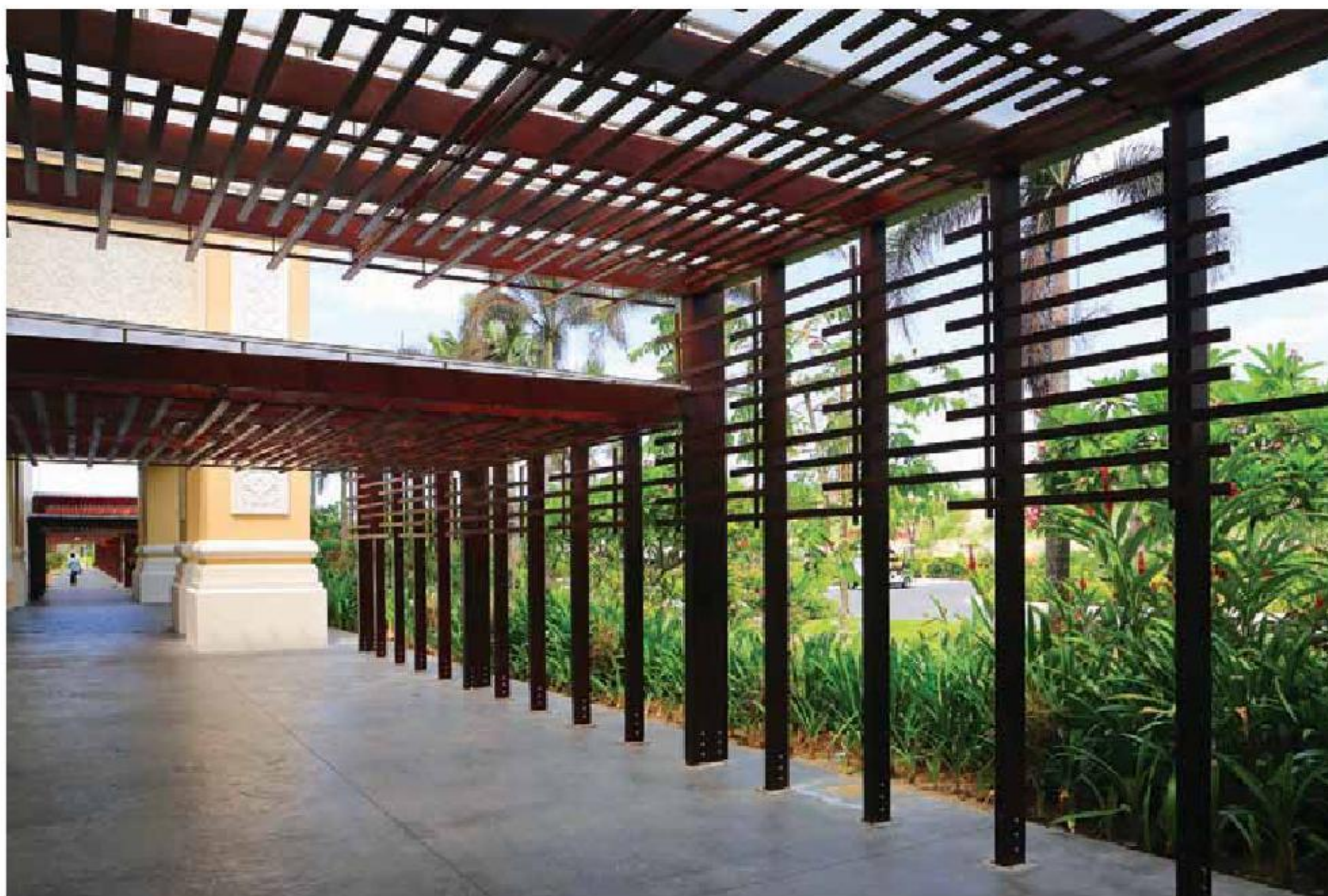
Ảnh trang bên Mặt nhà hướng nắng gắt có thể dùng lam mảng lớn đi cùng những mảng khối lối thụt, kết hợp cây xanh để giảm bức xạ bên ngoài rọi vào. Ảnh trên Từ làm đường dẫn trong resort Hồ Tràm đến bọc ngoài văn phòng Unilever, hay đan xen ở Thư viện đại học Cần Thơ, có thể thấy ứng dụng của hệ lam hiện nay khá phong phú, đa dạng.
