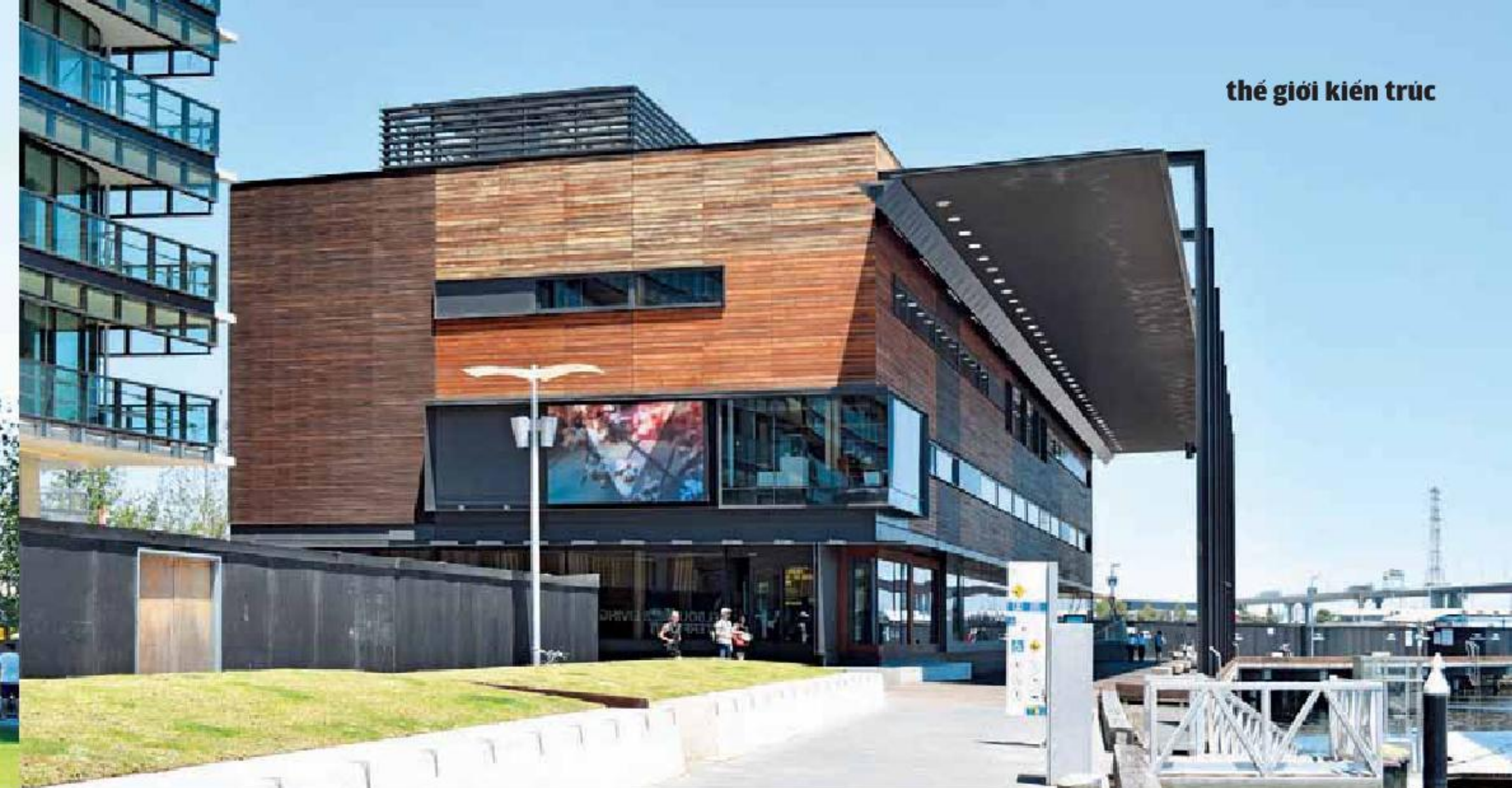
Ảnh hai trang Tòa nhà thư viện có hình khối hộp đơn giản, Gỗ ốp trên mặt tòa nhà là gỗ Ironbark đã 100 năm tuổi, lấy từ một cây cầu đã bị tháo dỡ ở bang Queensland. Mặt quay ra bờ cảng của thư viện có mái che lớn nhằm cản bớt ánh nắng gay gắt buổi chiều.
