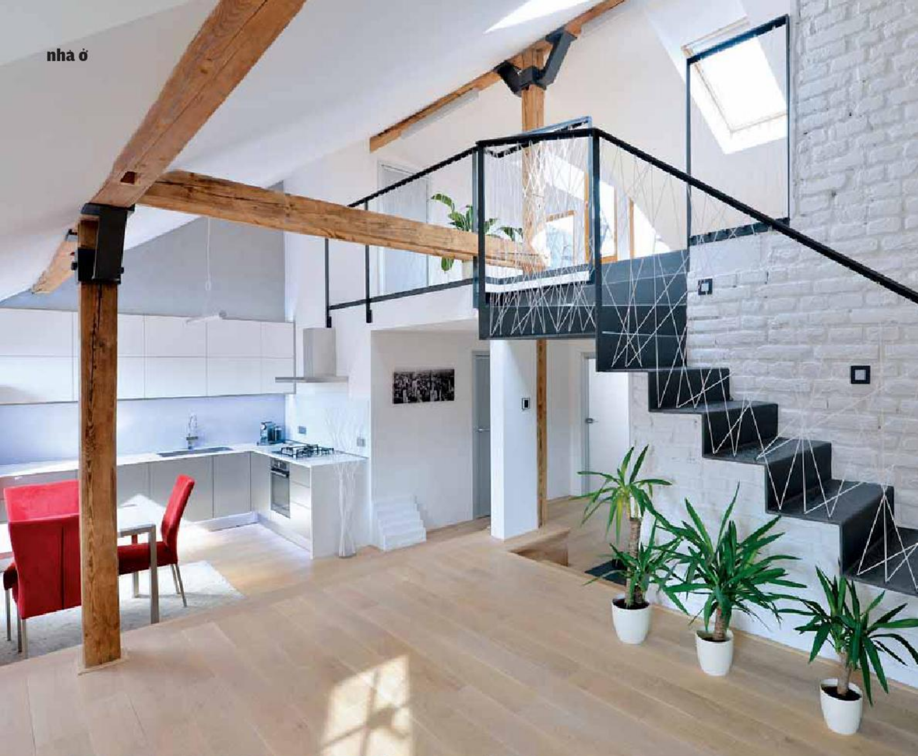
Ảnh trên và dưới Ánh sáng của căn áp mái được lấy từ những ô cửa vát trở từ mái nhà. Các dầm gỗ chịu lực được gia cố bản lề thép tạo nên vẻ đẹp mạnh và chắc chắn.
