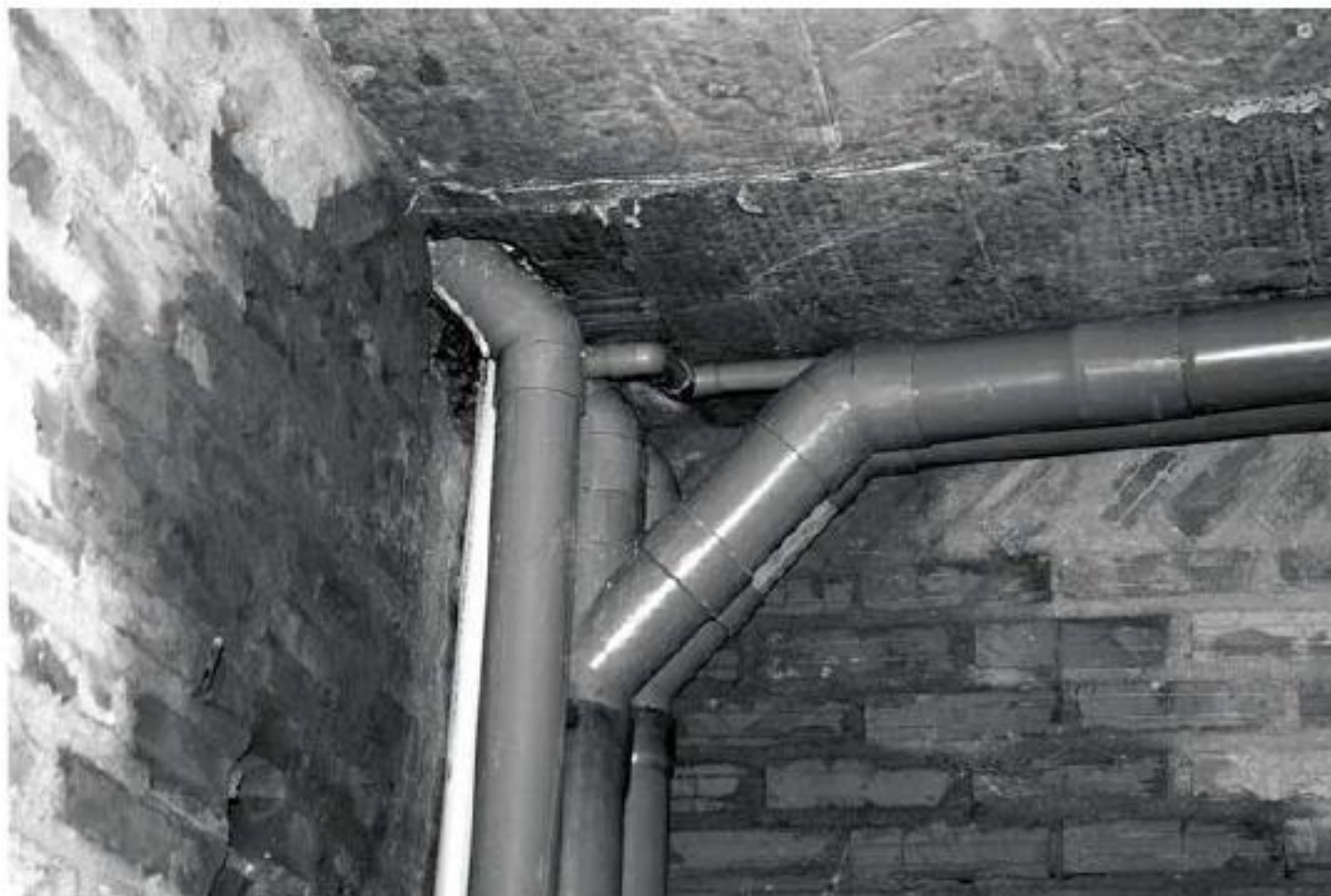
Ảnh trái Các đầu nối ống cấp thoát nước là vị trí xung yếu dễ gây ra rò rỉ và thấm. Ảnh phải Chống thấm phải bắt đầu thực hiện từ khi thi công công trình.
