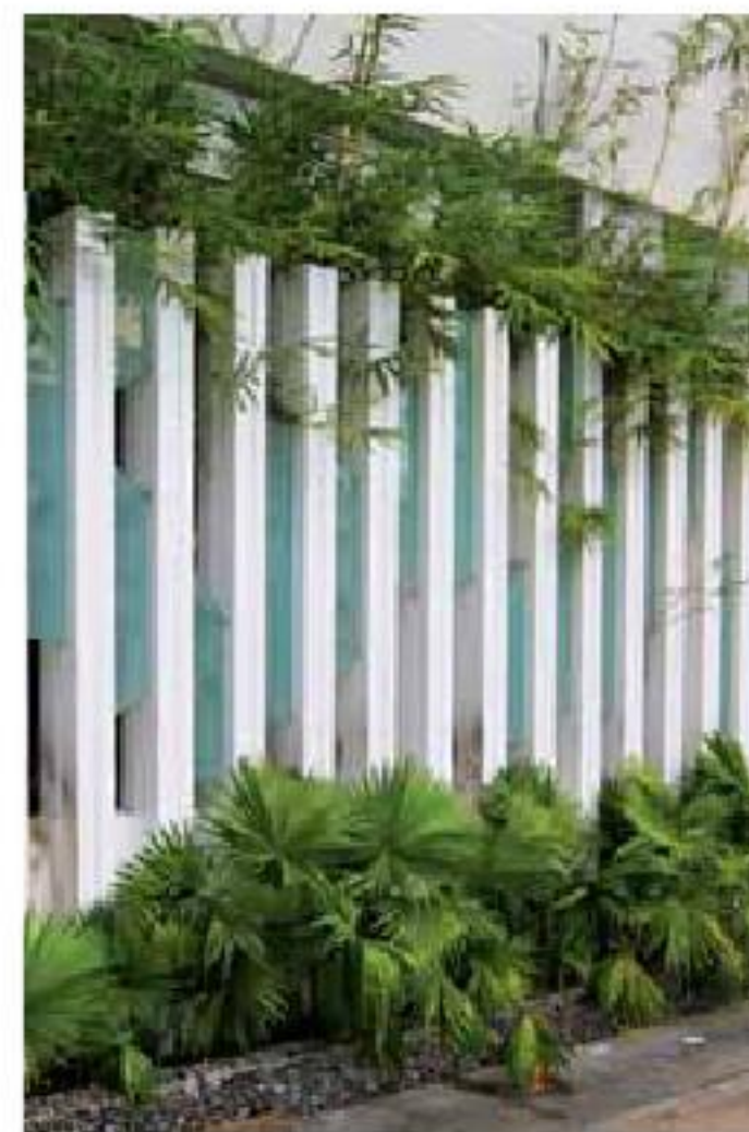
Những giải pháp tường rào, bao che bằng hệ lam giúp lọc nắng, ngăn nhiệt tốt mà vẫn thoáng gió, kín đáo.
