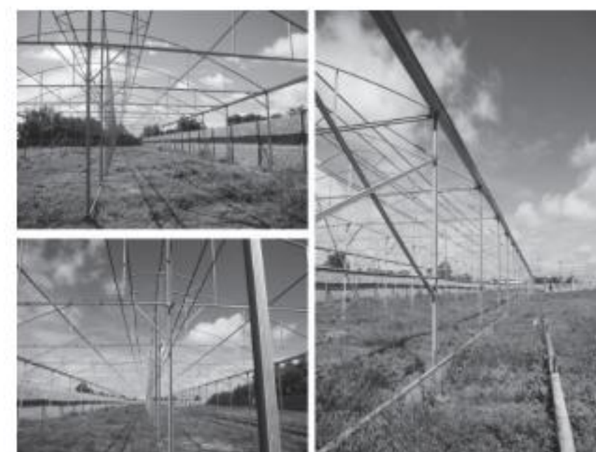
Một công trình nhà kính của Công ty Nông Việt.
