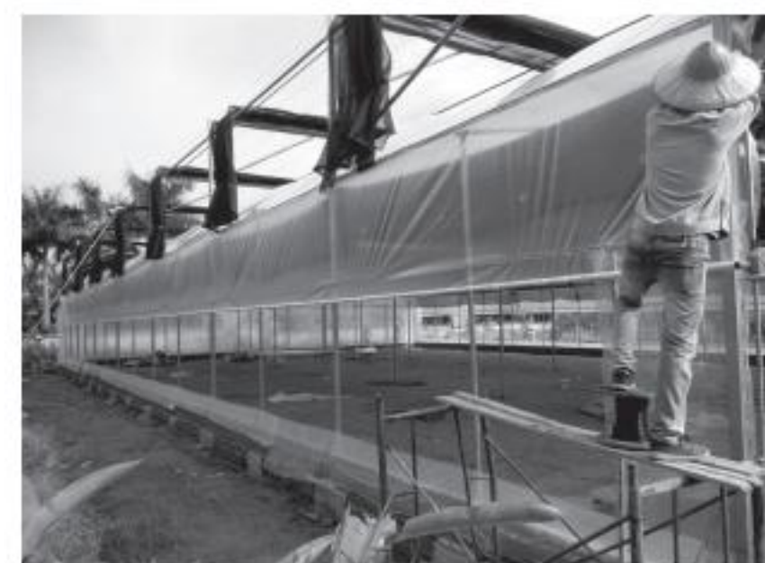
Nhân viên Công ty An Phát thi công lắp đặt nhà lưới.
