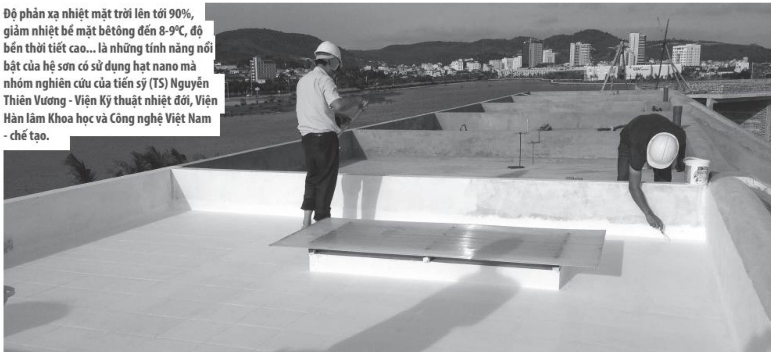
Thi công chống nóng mái tum bằng sơn phản xạ nhiệt mặt trời tại khu đô thị The Little Vietnam, Quảng Ninh.
