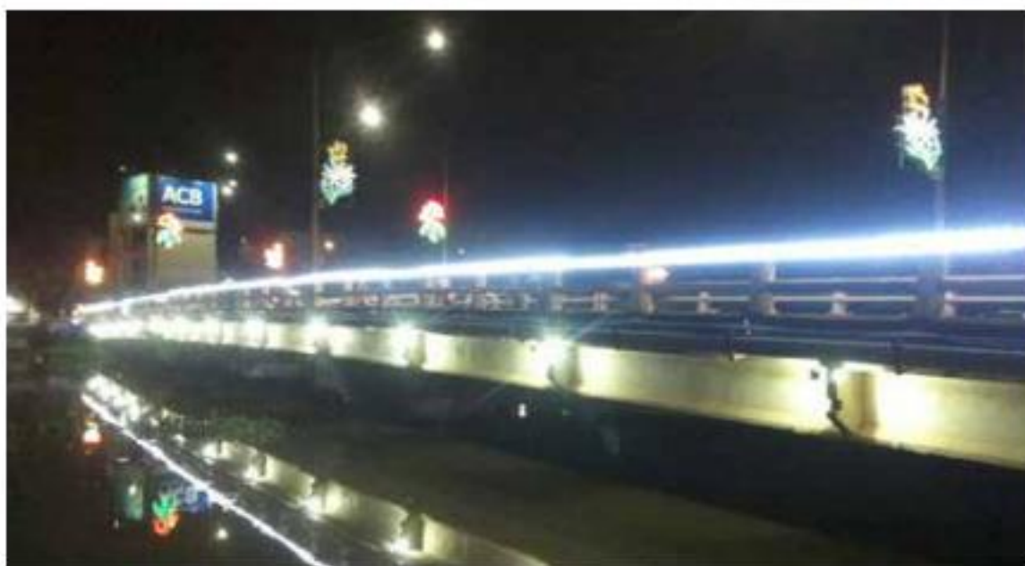
Hệ thống chiếu sáng tiết kiệm, thông minh và thân thiện môi trường trên cầu Đức, thành phố Tân An.
