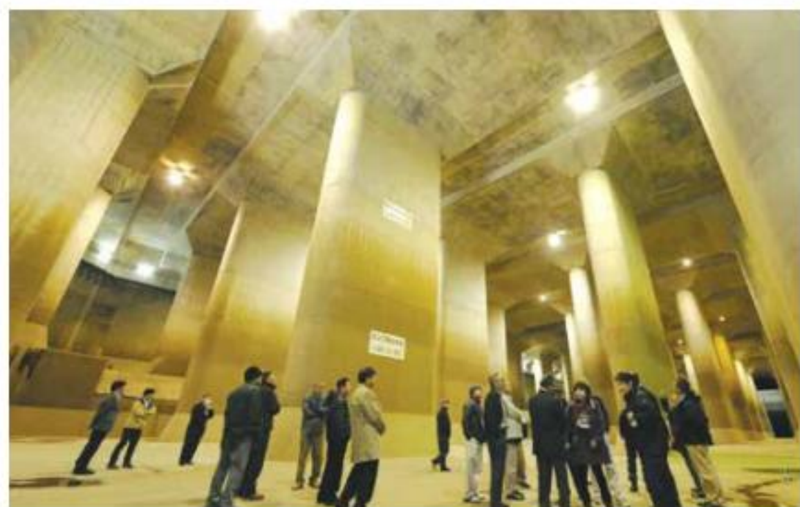
Khu vực hồ chứa của hệ thống kênh phân phối ngầm để thoát nước khỏi khu vực trung tâm thành phố Tokyo. Ảnh: The Japan Times
