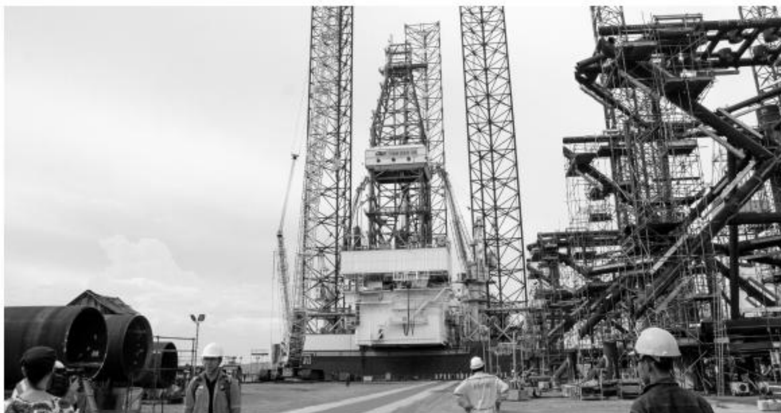
Giàn khoan tự nâng Tam Đảo 05 - thế hệ sau của Tam Đảo 03 - được hạ thủy tại Bà Rịa - Vũng Tàu.
